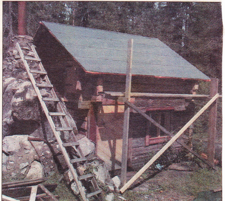
Saknar trätak. Nu ska bara trätaket läggas på, därefter är Styggenstugan klar att invigas på Styggendagen den 20 augusti.
