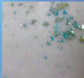
MACCHIE BLU (CRACK)
