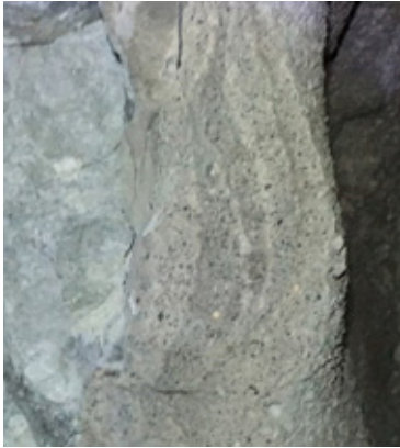
Fig. 4. Buna adherencia entre capas de concreto lanzado
