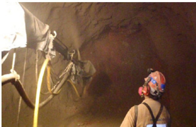
Fig. 2. Aplicación robótica de concreto lanzado
