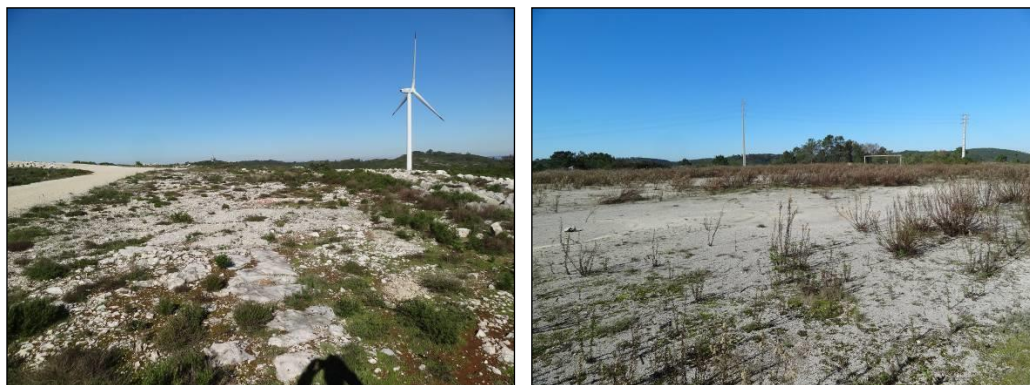
Figura 46 – Vista geral do terreno na área escolhida para o estaleiro (solução 1 e solução 2)
