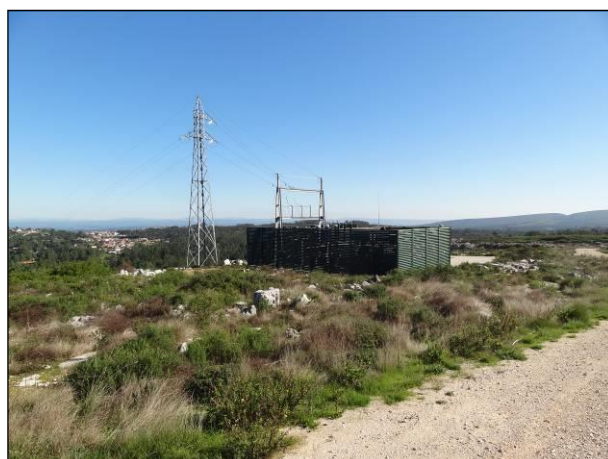
Figura 6 – Área proposta para localização alternativa da subestação (geometria simétrica à subestação de PE Marvila I existente – na foto)
