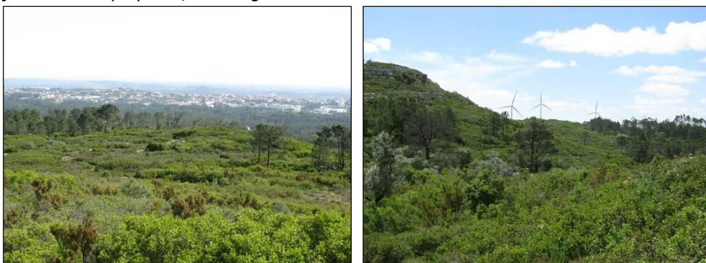
Figura 41 – Vista geral do terreno no caminho entre o AG 1 e o AG A e entre o AG 6 e o AG 8
