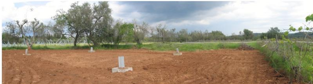
Execução das fundações dos apoios de linha
