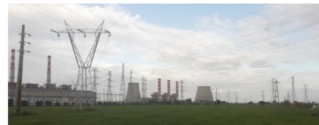
Troço final de linha: concentração de subestações, linhas MAT e Central do Ribatejo
