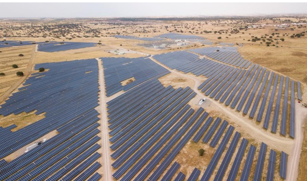
Figura 1 – Exemplo de parque solar com estrutura seguidora
