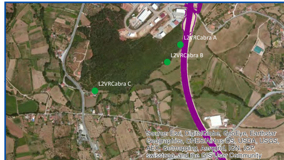
Lote 2 - Viaduto sobre o rio Cabra, aprox. ao km 2+650
