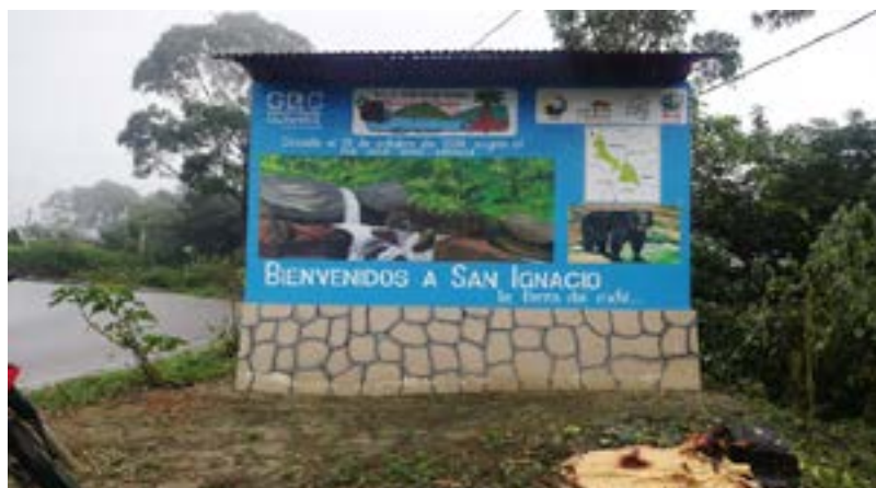
Figura 27. Colocación de murete, ACR- BCHCCH
