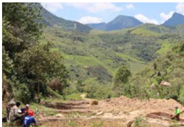
Figura 112. Construcción de pozas.
