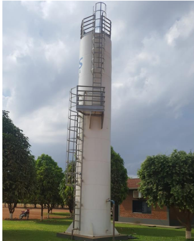
Figura 25-Caixa d'água já construída no imóvel Fonte: Autores (2023)
