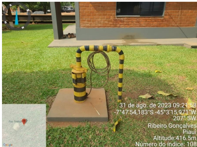
Figura 24-Poço já perfurado no imóvel Fonte: Autores (2023)
