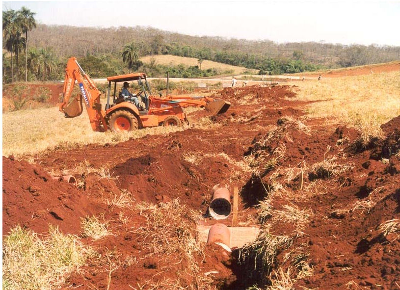
Figura 72 – Emissário de Esgotos Sanitários Tomador: Prefeitura Municipal de São José da Bela Vista
