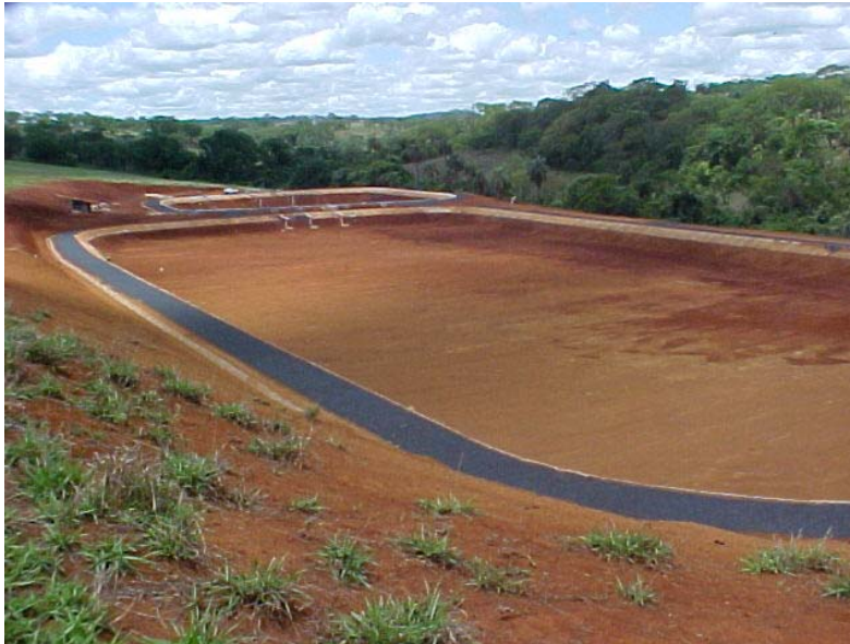
Figura 68– Estação de Tratamento de Esgotos do município de São José da Bela Vista. Tomador: Prefeitura de São José da Bela Vista
