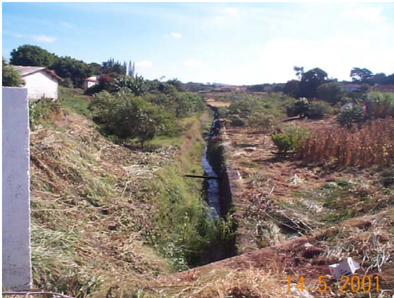
Figura 64 – Canalização do Córrego Mato Grosso, no município de Altinópolis Tomador: Prefeitura Municipal de Altinópolis
