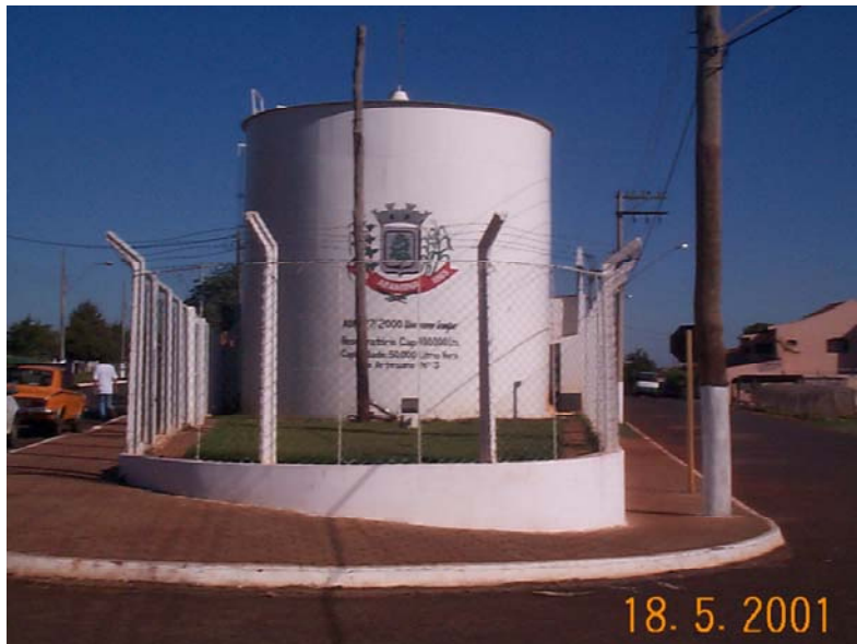
Figura 48 – Equipamento para poço profundo e Reservatório de Água. Tomador: Prefeitura Municipal de Aramina.
