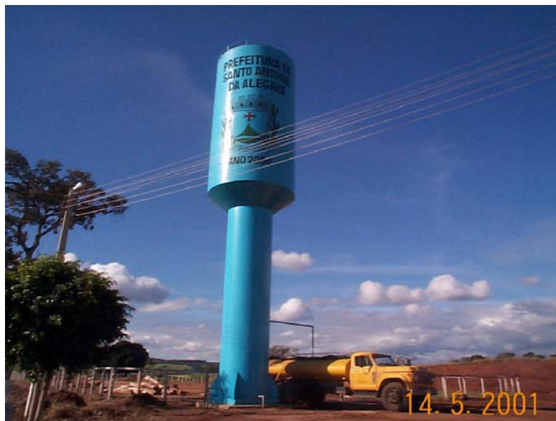
Figura 49 – Reservatório de Água Tomador: Prefeitura Municipal de Santo Antônio da Alegria
