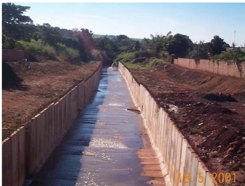
Figura 55 – Drenagem e Proteção de leito, município de Igarapava. Tomador: Prefeitura Municipal de Igarapava.
