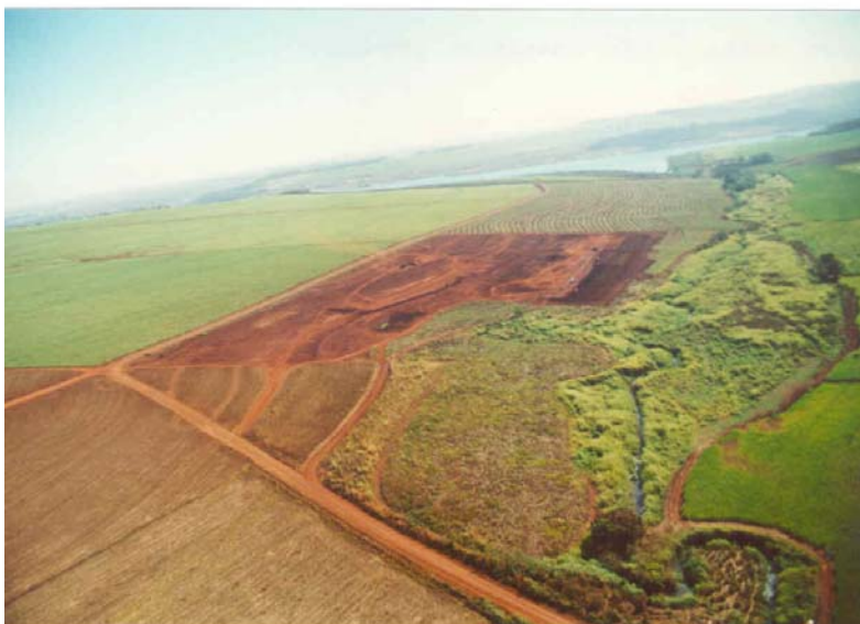
Figura 71 - Estação de Tratamento de Esgotos do município de Igarapava Tomador: SABESP
