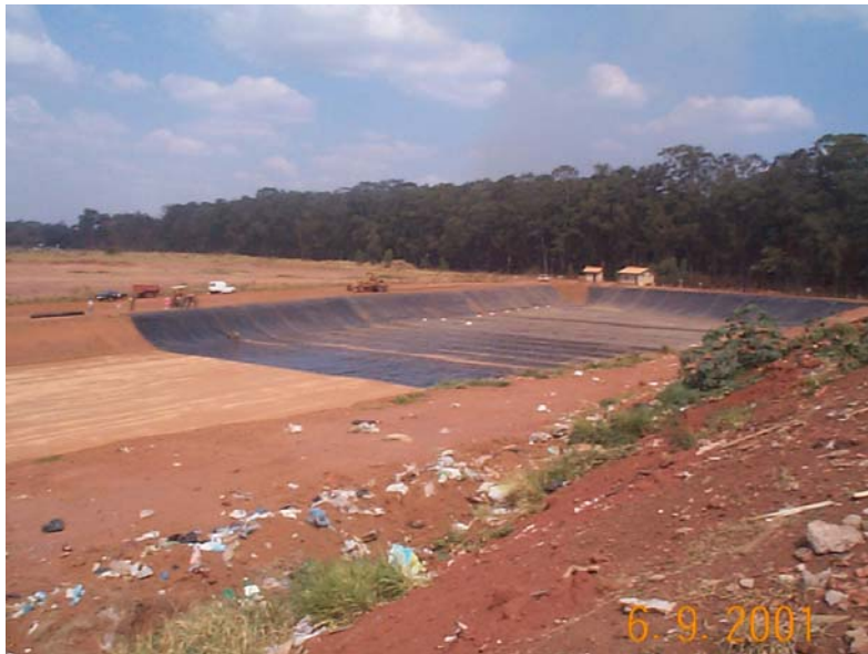
Figura 54 – Implantação de melhorias no Aterro Sanitário do município de Batatais Tomador: Prefeitura Municipal de Batatais.
