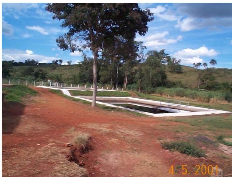
Figura 59 – Lagoas do Matadouro do município de Itirapuã Tomador: Prefeitura Municipal de Itirapuã
