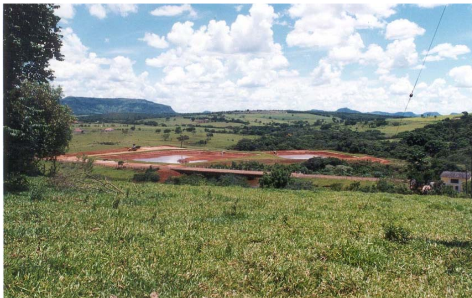
Figura 58 – Estação de Tratamento de Esgotos do município de Santo Antônio da Alegria Tomador: Prefeitura Municipal de Santo Antônio da Alegria.
