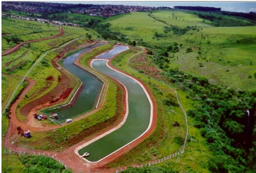
Figura 47 - Estação de Tratamento de Esgotos do Jardim Aeroporto, município de Franca/SP. Tomador: Sabesp
