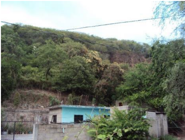
Imagen 57.- Al fondo de la imagen se puede apreciar la parte de rocas que presenta un problema para la población de la cabecera municipal ante un posible derrumbe. Fuente: Consultoría Leviuqse
