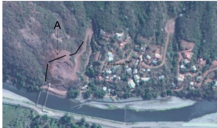
Imagen 61.- Á.- Área del posible derrumbe. Ubicación del derrumbe en la localidad del Balseadero en donde se encuentra un posible derrumbe en esta localidad. Fuente: Elaboración propia en base al Google Earth-
