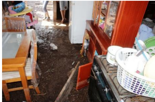
Imagen 6.- El agua penetro las viviendas afectando todos los muebles de los habitantes del Organista. Inundación registrada en julio 2013. Fuente: Consultoría Levuiqse.
