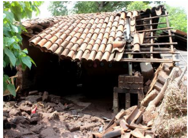
Imagen 97.- Las construcciones de mampostería resultaron endebles antes la corriente de arroyo que terminó por colapsarlas. Foto tomada por Joel Avilés Alejandre
