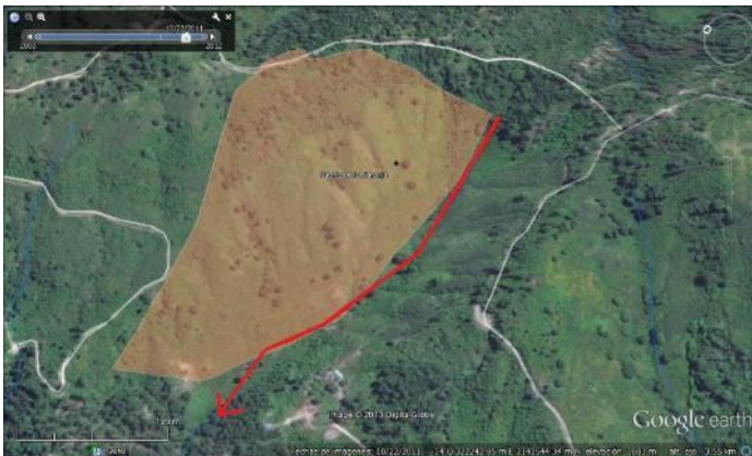
Imagen 19.- Imagen Satelital de la localidad de Puerto de la Naranja en donde se aprecia un movimiento de masas cerca de la localidad. Fuente: Google Earth.
