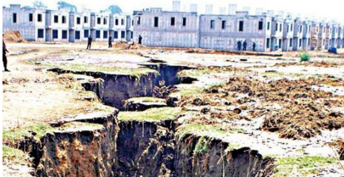
Imagen 64.- En la imagen se puede apreciar un agrietamiento registrado cerca de un desarrollo inmobiliario en Iztapalapa en la Cd. De México. Fuente: http://www.oem.com.mx/elsoldemexico/notas/n2989110.htm
