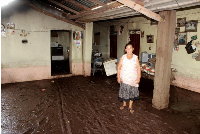
Imagen 98.- La localidad El Plátano los daños se registraron fueron en dos viviendas en las cuales la perdida fue parcial. Foto tomada por Joel Avilés Alejandre
