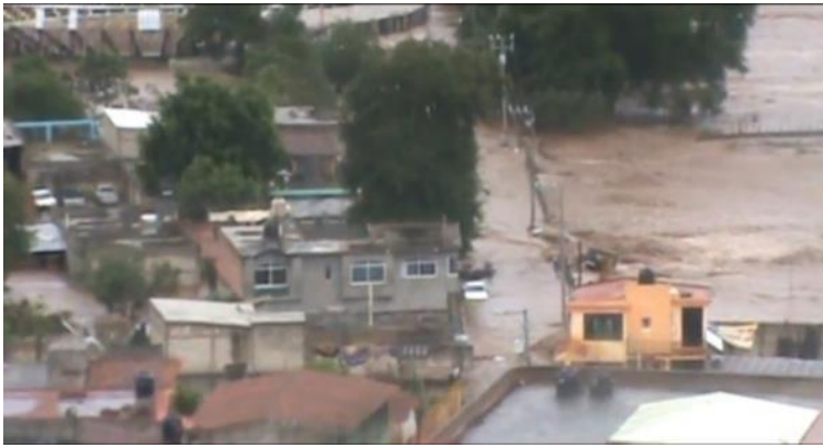
Imagen 88.- El río Tuzantla sobrepasa su límite y se desbordo provocando inundación en la cabecera en el 2010. Fuente: Medio informativo Quasar
