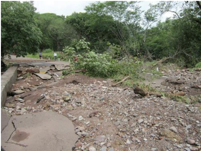
Imagen 52.- Además de flujos por lodo, también se ocasionaron daños por flujos cerca del arroyo ya que este género grandes movimientos de tierra y piedras además de árboles en La Quiringuca. Foto tomada por Joel Avilés Alejandre
