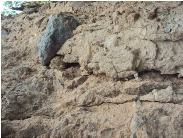
Imagen 58.- En esta imagen se puede apreciar el tipo de suelo en el que se encuentra las rocas y las pequeñas fisuras que presentan la cual poner en riesgo de un posible desprendimiento de estas. Fuente: Consultoría Leviuqse
