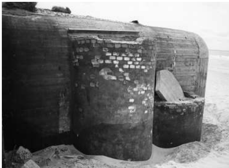
Nøddugang til venstre på ydersiden af bunker ved Søndervig. Til højre granatfælden ved foden af skorstenspiiben.
