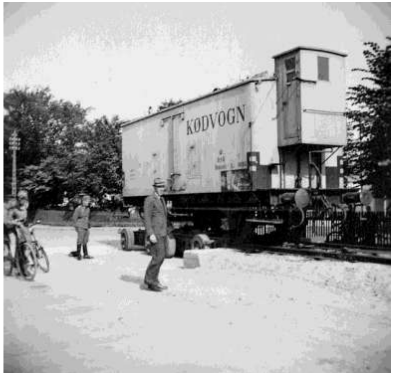
Jernbanevognen trækkes over på Culemeyeren og fastspændes.
