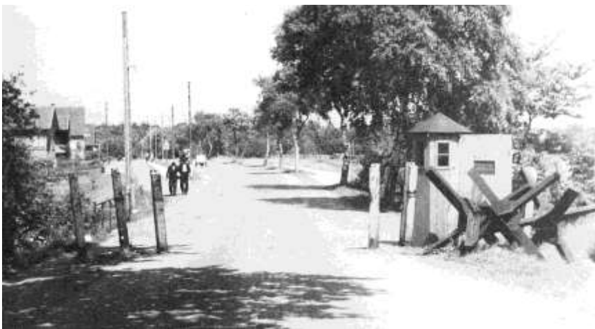
Kontrolposten i Lysbro. Foto. SLA
