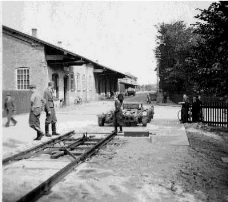
Følgende 3 billeder er fra Frederikshavn, som havde et tilsvarende anlæg. Culemeyervognen bliver her trukket hen til rampen og fastgjort. Fotos: SB
