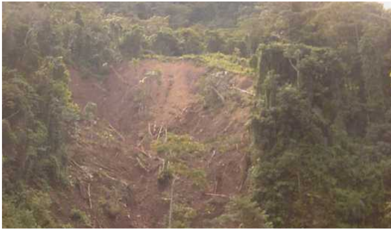
FOTO 17: Zonas con problemas de erosión y derrumbes.
