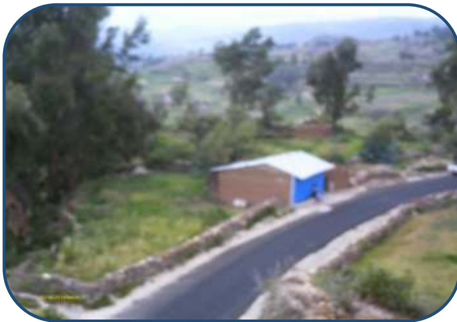
Fotografía N° 07: Nuevas vías de acceso.
