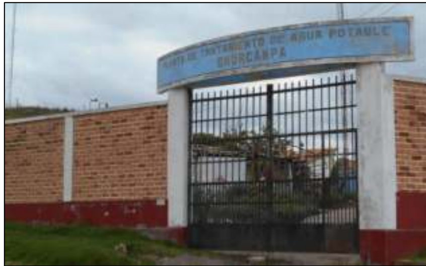
Fotografía N° 03: Planta de Tratamiento de agua Potable de Churcampa
