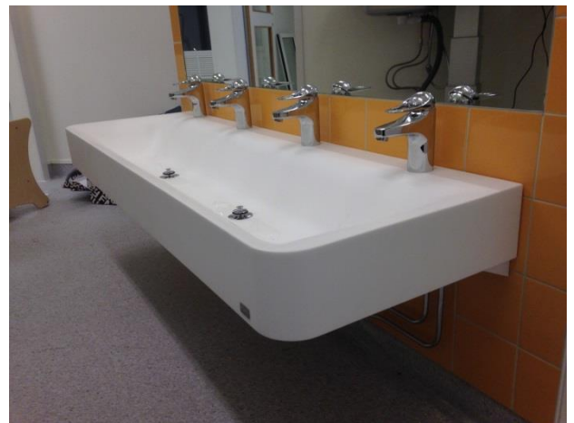
Tvättträna i corianmaterial med rundade hörn, spegel och kakel enligt referensritning A2, Vasan, Vasaloppsvägen 112
