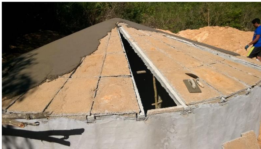
Figura 5 - Coberta sendo concluída.
