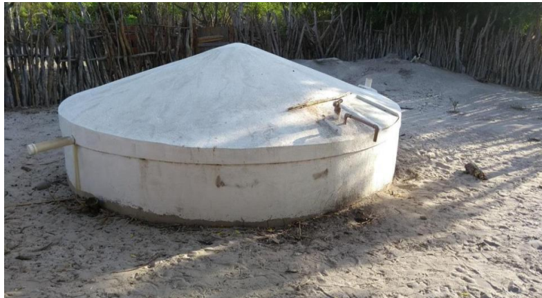
Figura 04- Cisterna de Placas em uma residência na comunidade de Lagoa do Mato.
