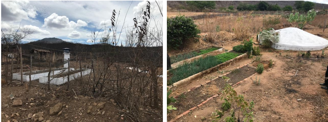
Figura 7 – Canteiros econômicos e cisterna de placas, tipo enxurrada, de 52.000 litros.
