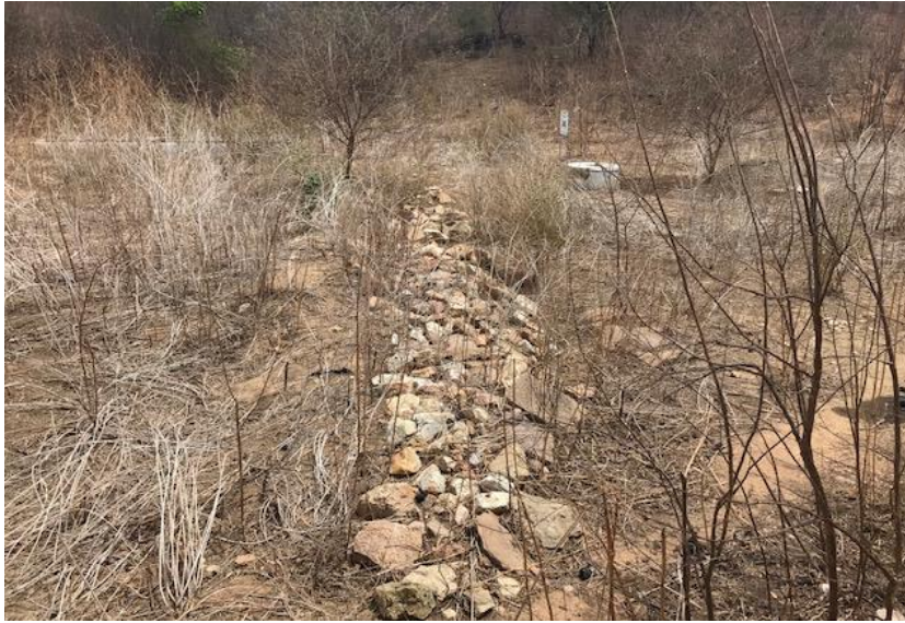
Figura 2 – Barragem subterrânea, modelo “Costa e Melo”.
