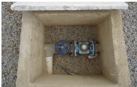
Figura 05 - Registro na entrada da ETA.
