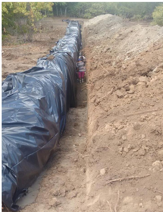
Figura 1 – Barragem subterrânea, em construção, 2015.
