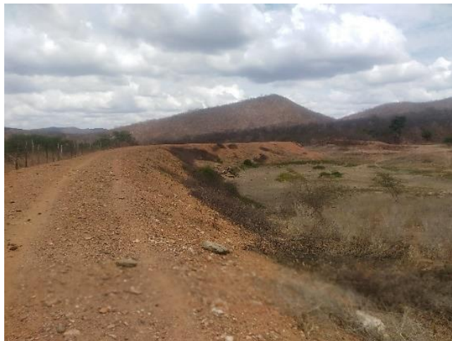
Figura 1 - Barragem de terra.
