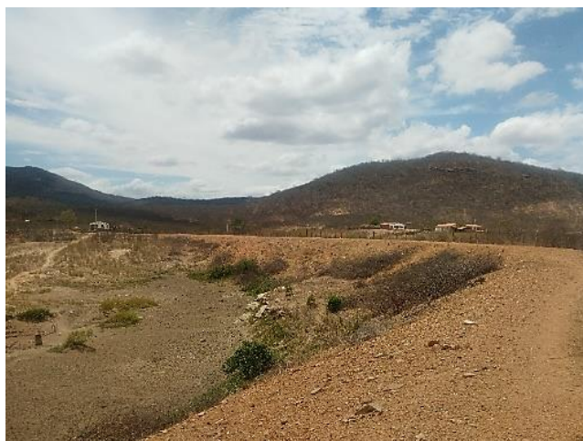
Figura 4 - Barragem tem o formato de quase 90 graus.
