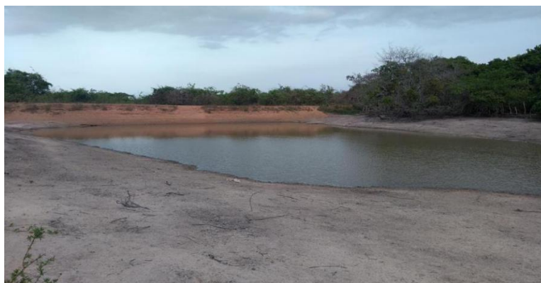
Figura 06-Barragem Localizada na comunidade de lagoa do Mato (foto tirada em: 11/11/19).
