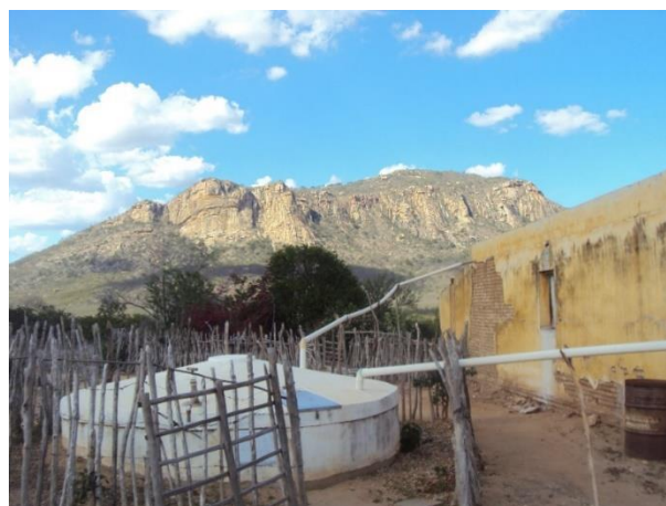
Figura 14 - Cisterna de placa na fazenda Campo Nobre no município de Tamboril.
