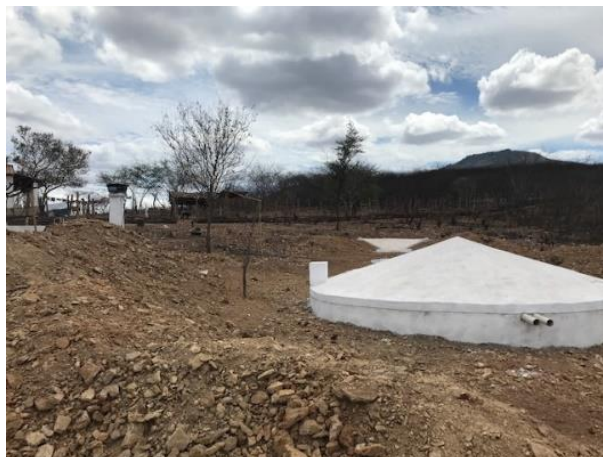
Figura 13 - Cisterna do tipo enxurrada na localidade de Água Morta.
