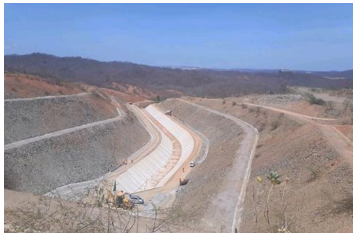
Figura 1- Trecho da obra CAC no Assentamento 10 de Abril.
