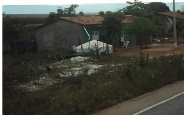
Figura 4 - Cisterna de placa em uma residência no município de Novo Oriente.
