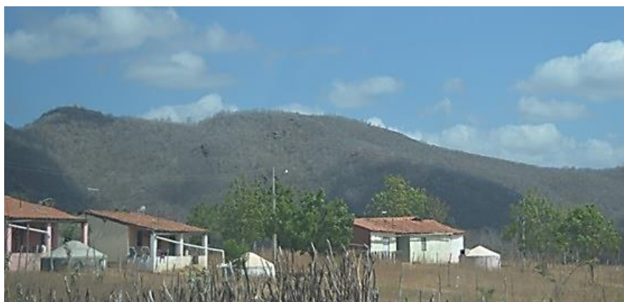
Figura 4- Cisternas de placas na zona rural de Tejuçuoca
