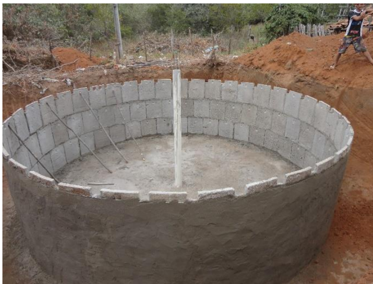
Figura 3 – Cisterna com as paredes de placas levantadas.
