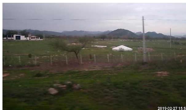
Figura 7 - Cisterna de placa de forma cilíndrica (enxurrada) no município de Irauçuba
