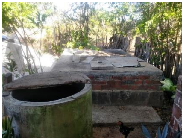
Figura 11 - Cisterna retangular em alvenaria (blocos cerâmicos).
