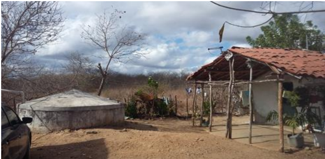
Figura 2- Cisterna rural de placas instalada na comunidade Pedra Branca, Sobral-CE.
