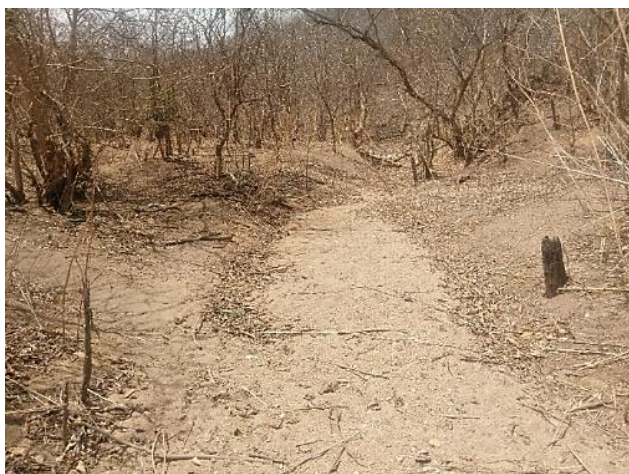
Figura 6 - Riacho totalmente seco na jusante da barragem.
