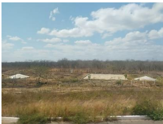
Figura 2 - Três cisternas de placa de concreto em uma fazenda no município de Irauçuba.
