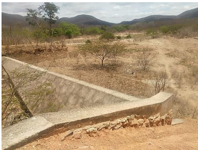
Figura 2 - Sangradouro feito de concreto e pedra.
