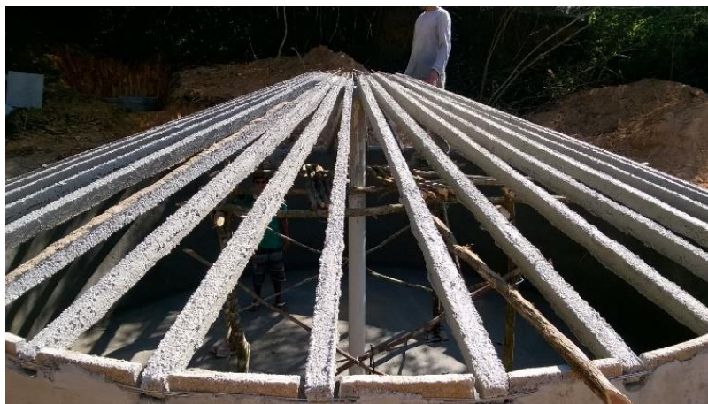
Figura 4 - Caibros apoiados nas paredes para receber a cobertura.
