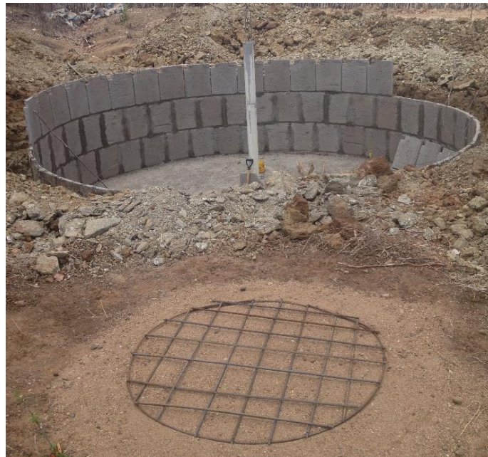
Figura 2 – Cisterna de placas de 52.000 litros, em construção.
