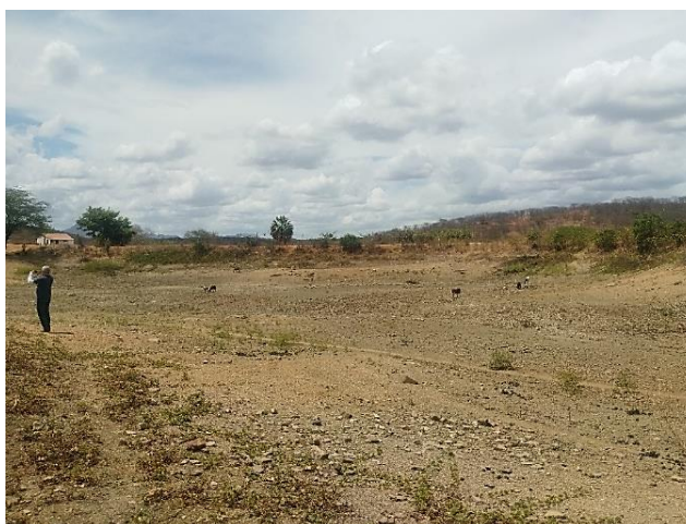
Figura 7 - Barragem de salvação totalmente seca.
