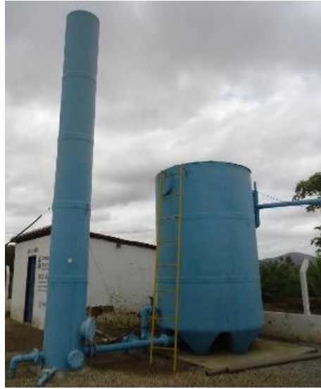
Figura 07 - Torre de nível.
