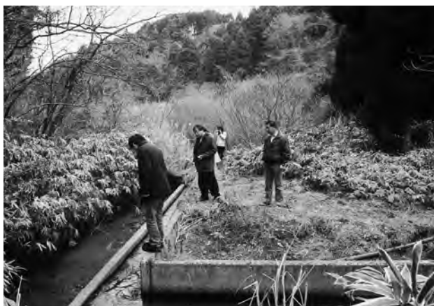
Pho. I 4-1-5 蛤水道水源付近
