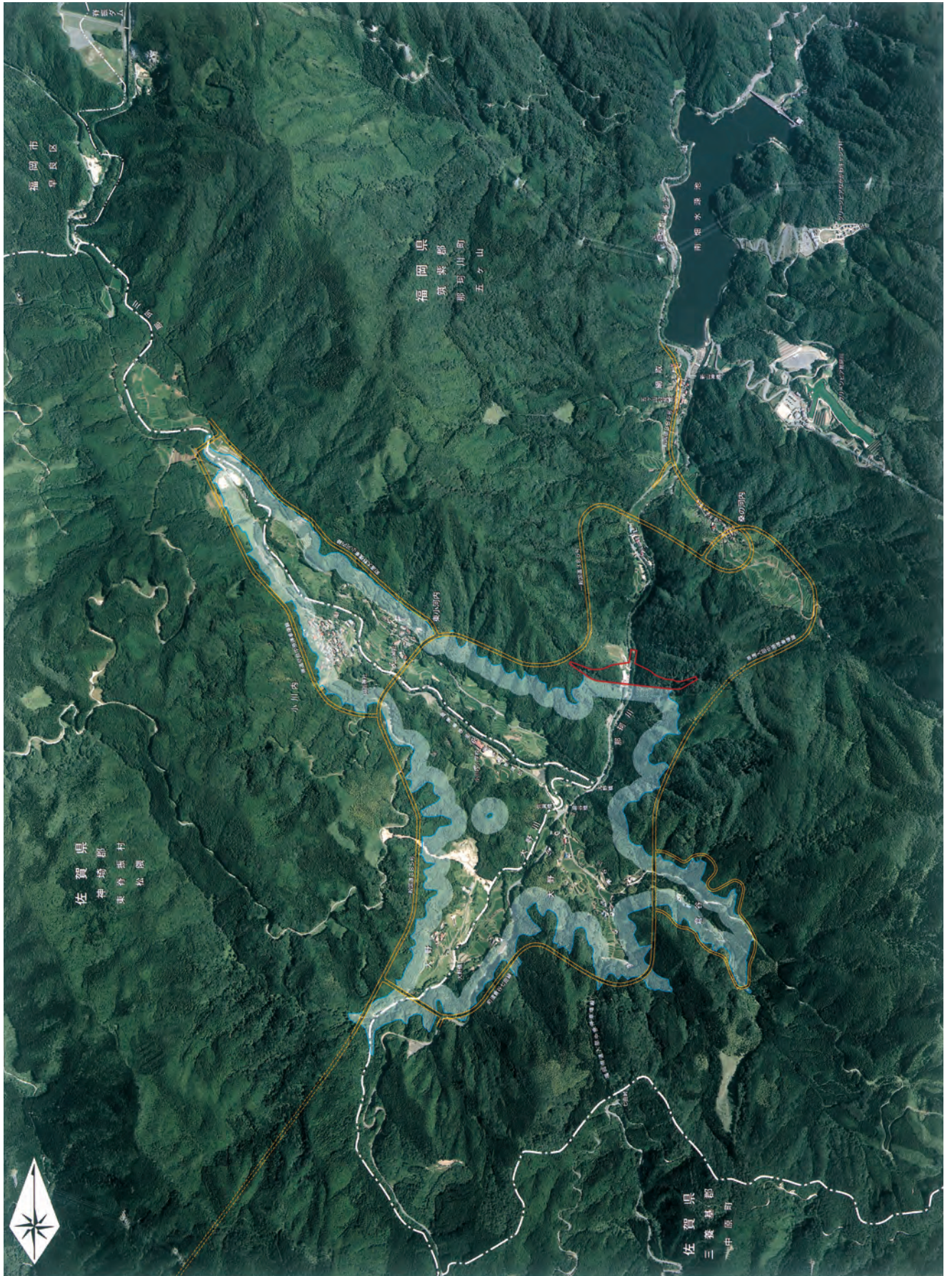
五ヶ山ダム施工地航空写真〔福岡県五ヶ山ダム建設事務所提供〕
