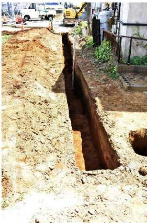
トレンチ西部完掘状況
