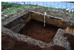
トレンチ完掘状況
