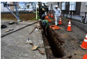
トレンチ東部調査風景
