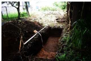
トレンチ 1 検出状況
