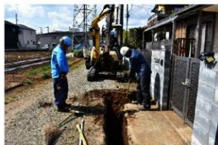
トレンチ北西部掘削状況
