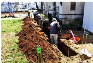
トレンチ西端部掘削状況
