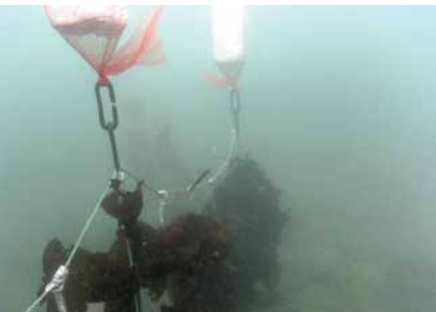
Fig. 33. Cortina instalada en el fondo marino. Se observa la unión entre la cortina y la boya con un eslabón de cadena de plástico.
