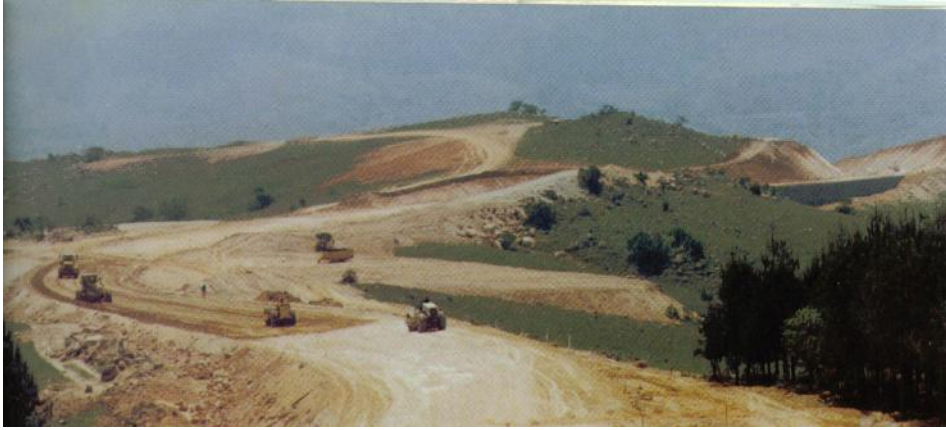
Foto 4: Vista del terraplén de una carretera rural.
