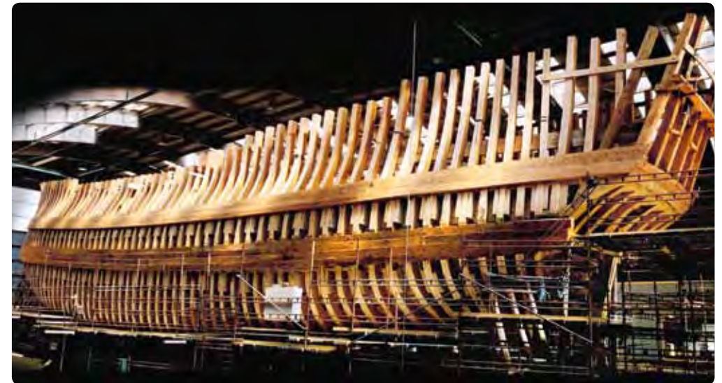
Göteborgs förtimring färdig och bordläggningen påbörjad.
