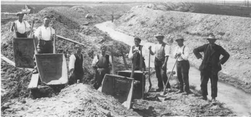
Arbejdssjak i færd med grøftegravning i marsken ca. 1925. Foto: Tønder Lokalhistoriske Arkiv.
