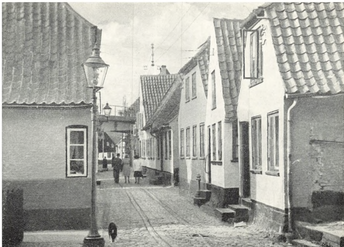
Havbogade med de nette små gavlhuse er utvivlsomt Sønderborgs hyggeligste gade. Ved foden af det bakkedrag, hvorpå byen breder sig, ligger gaden som en lille stilfærdig verden for sig. Gadebroen, der ses i taghøjde, er tilkørselsrampen til Allsund-broen. (Fot. Herluf Lykke).
