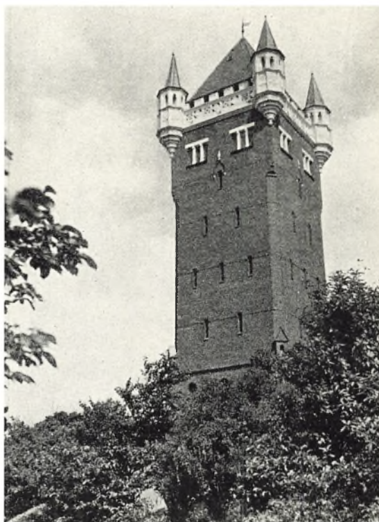
Vandtårnet på Bavneshøj ved havnen er bygget i 1897. Dette vandtårn er faldet heldigere ud end sine samtidige i andre byer. Det svære tårn er ikke uden monumental virkning og har da også vundet hævd som et slags vartegn for Esbjerg. (Fot. Sv. Türck).
