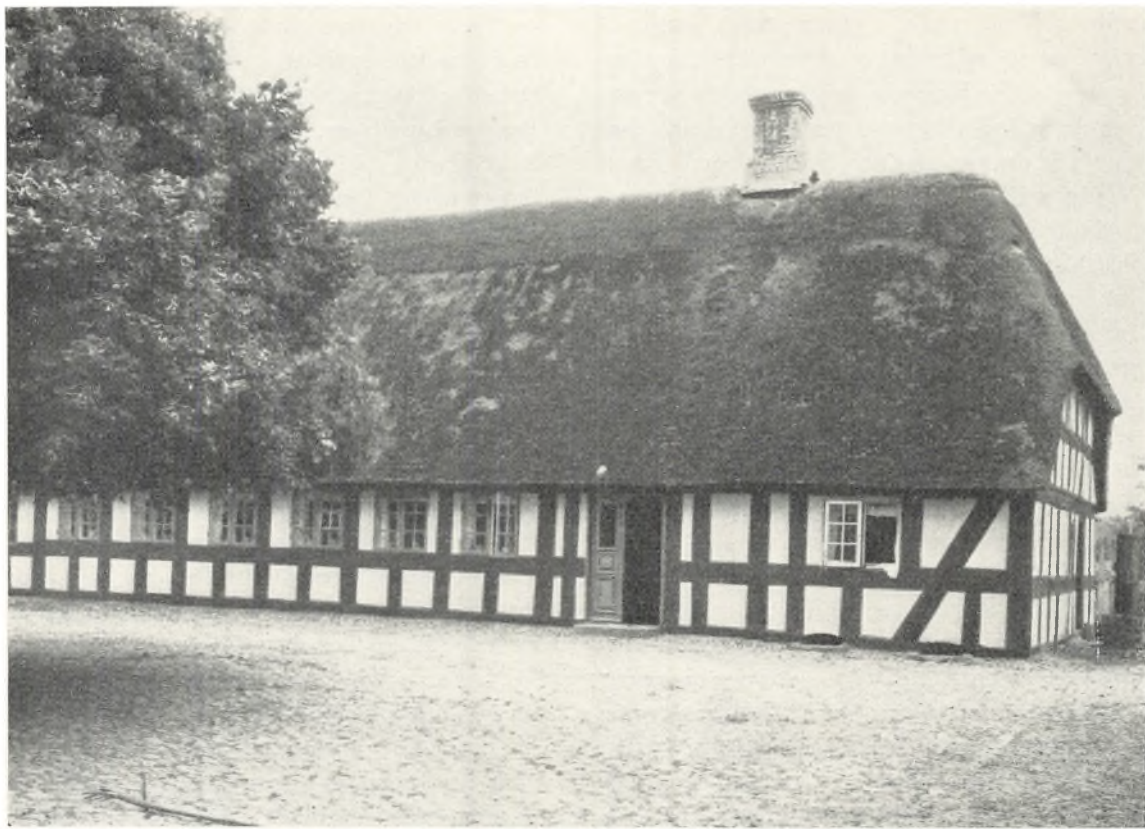
Gård i Højrup vest for Kolding. Billedet viser stuehuset, bygget i typisk østjysk bindingsværk. (Fot. 1932 H. Zangenberg).
