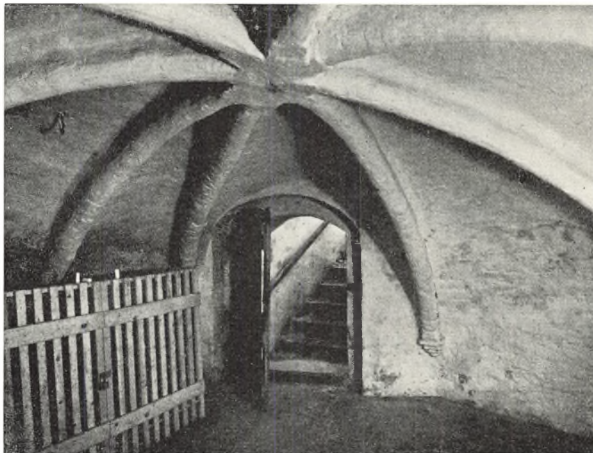
Hvælvet kælder under Brundlunds sydvesttårn. Det smukke hvælv er jævngammelt med det ca. 350 år gamle tårn. (Fot. Holt og Madsen).
