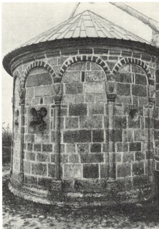
Apsiden på Staby kirke syd for Nissum Fjord. Den sjældent smukke og velproportionerede korrunding har to morsomme firklørevinduer. Kirken er bygget af kvaderhuggede granitsten og mørk jernal. (Fot. Kr. Hude).
