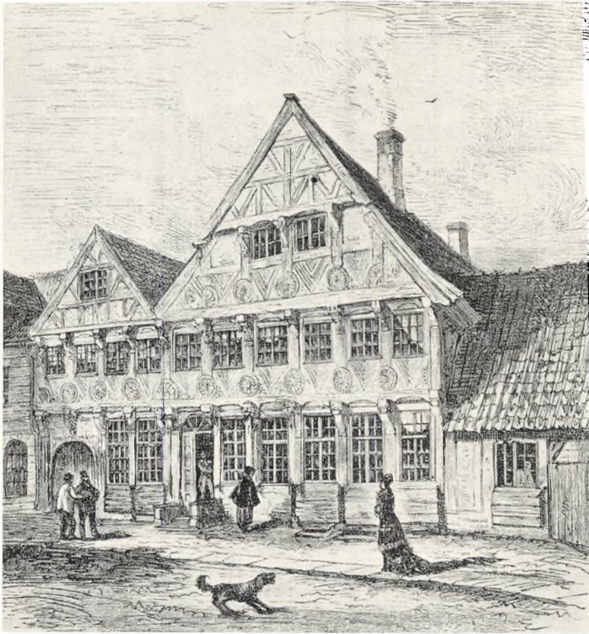
Den gamle provstegård fra 1591 på Naffet var ubetinget Haderslevs kønneste renæssancegård. Den blev nedrevet i 1880'erne. (Tegning af Mørk Hansen i Ill. Tid.).
