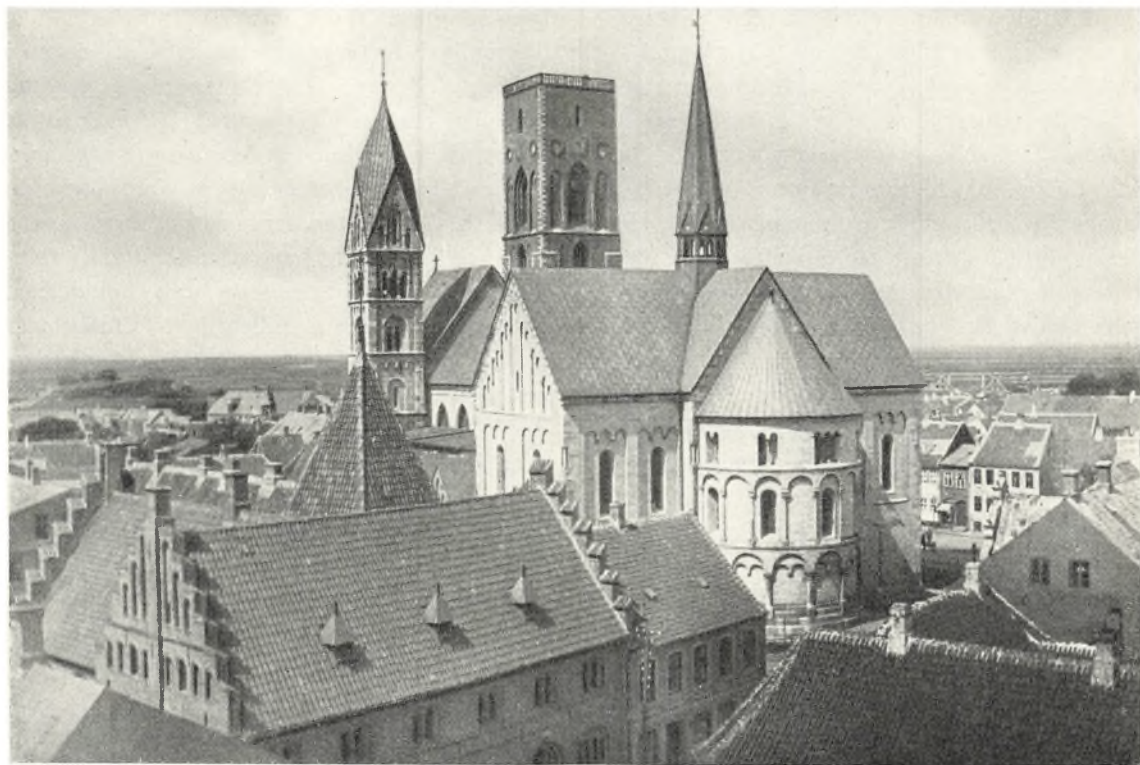
Ribe domkirke er i hovedsagen bygget af Bremer-sandsten og Andernach-tufsten. Byggeriet blev påbegyndt af biskop Thore, der faldt i slaget ved Fodevig 1134, og i hvert fald østpartiet har stået færdigt i 1145. (Fot. Bodil Hauschildt).
