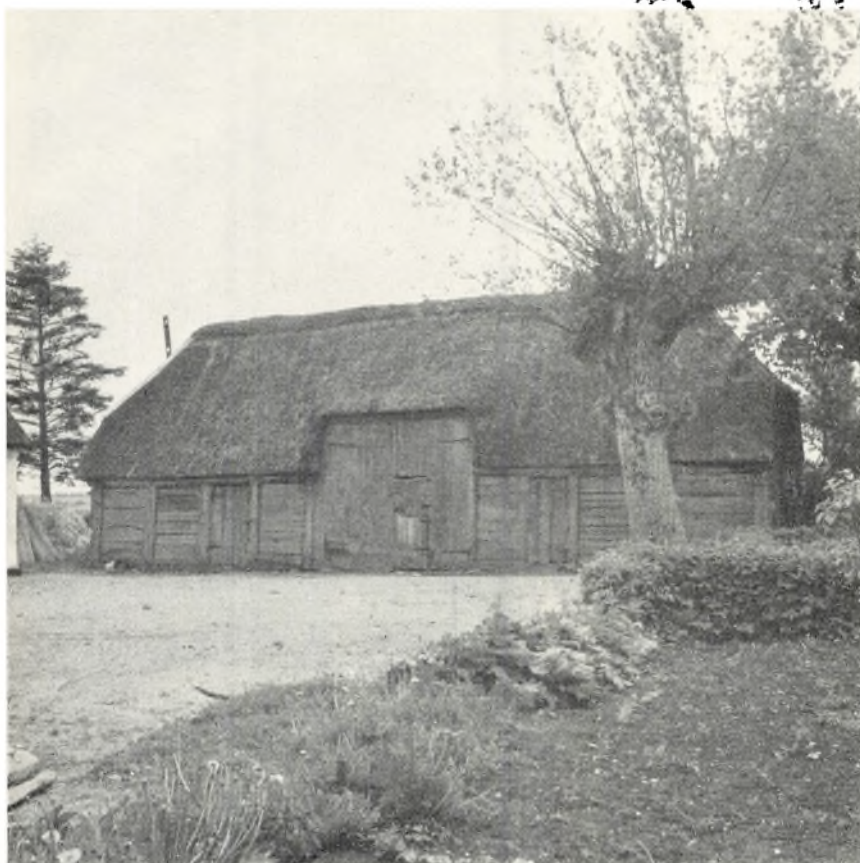
Lille bullade i Hvinderup ved Christiansfeld. Laden er en typisk repræsentant for de yngre bulhuse, der endnu kan ses i brug rundt om i det sydlige Jylland.
