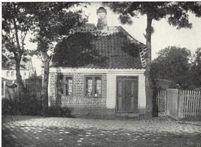
Bomhuset på Sønderland markerer den gamle købstads sydgrænse. Fra det lille hus, foran hvilket vejen var spærret ved bomme, krævedes indtil 1851 accise af trafikken til byen. (Fot. 1918 Hugo Matthiessen).
