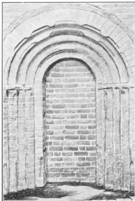
Den middelalderlige Dør-Portal.
