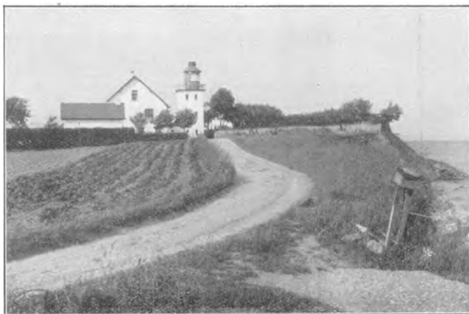
Fyret ved Tranekjær.
