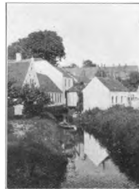
Assens gamle Strandmølle, i Baggrunden den ny Kommuneskolebygning.
