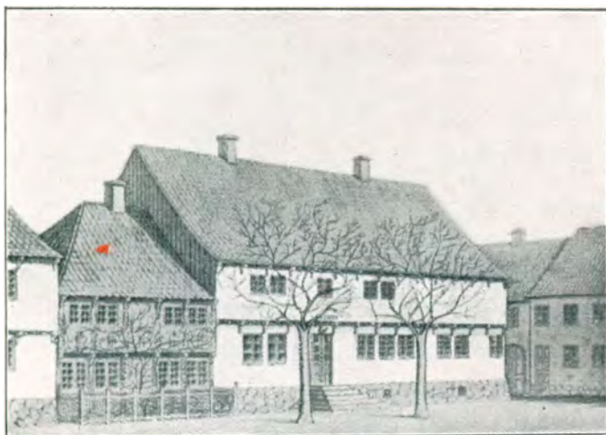
Assens Apotek før Ombygningen i 1847.
