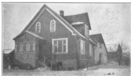
Elektricitetsværket i Nørre Broby.
