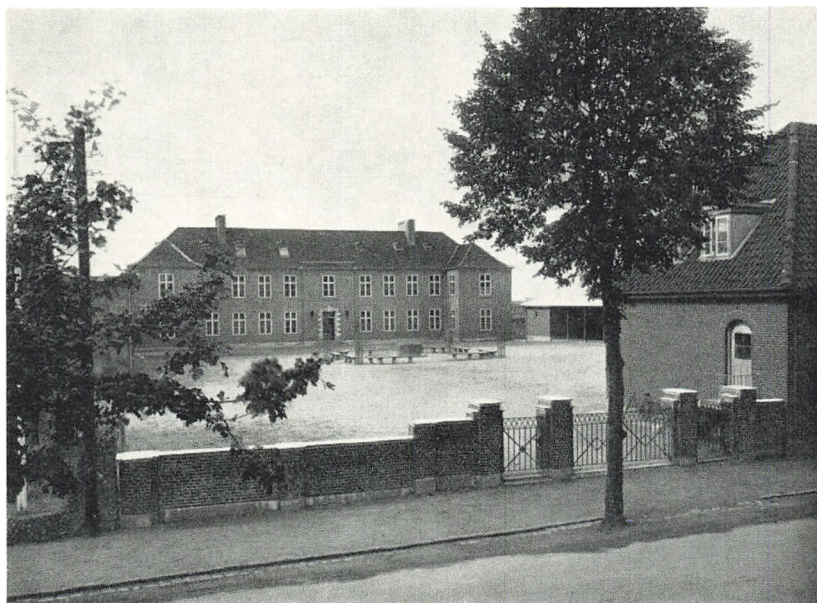
Borgerkolen, 1926-bygningen. (Arkitekt Rasmus Brüel).
