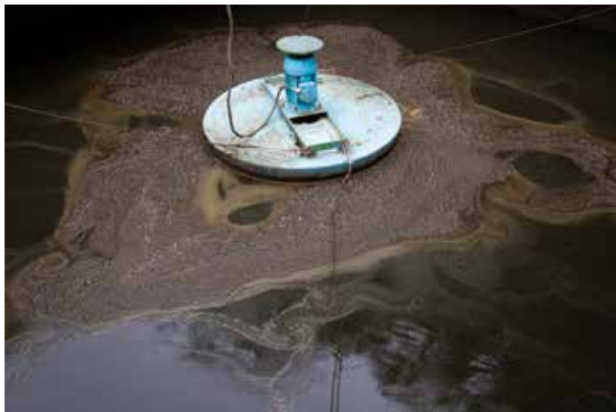
Aerador da Estação de Tratamento de Efluentes
