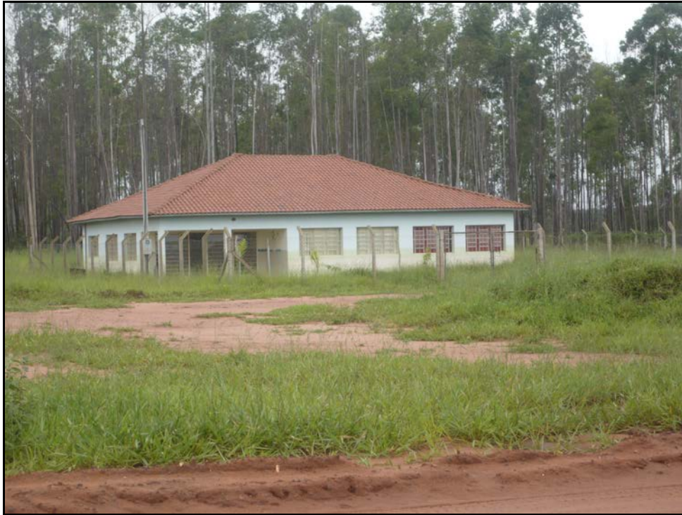
Figura 7.16 – Escola no Assentamento do INCRA. FONTE: Sueli Herculiani (2013). Levantamento de campo.
