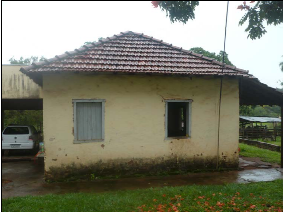
Figura 7.8 – Outra vista da ocupação caipira remanescente. Parte antiga da casa construída em taipa de mão.
