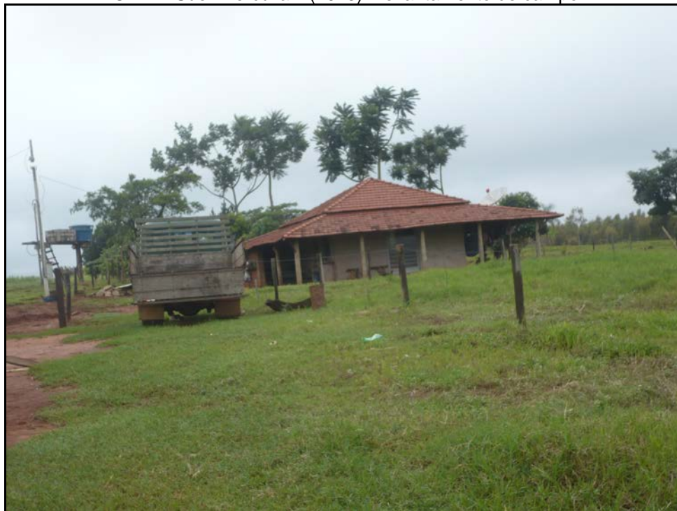
Figura 7.17 – Assentamento do INCRA. FONTE: Sueli Herculiani (2013). Levantamento de campo.
