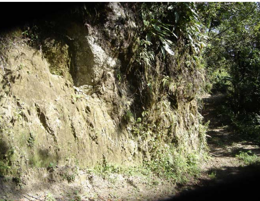
Foto 17 - Blocos e matacões de granito em solo de alteração argilo - arenoso rico em grânulos de quartzo e feldapato, que ocorrem nas encostas dos Morros.
