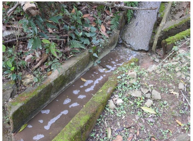
Foto 5.4-10: Despejo de água com produtos de limpeza oriundos da limpeza das áreas comuns dos residenciais.
