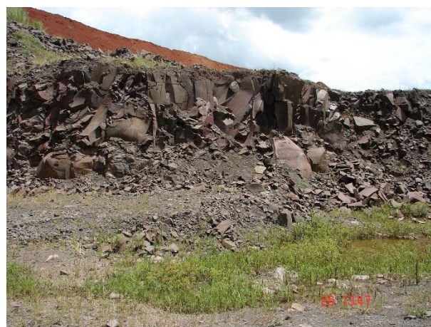
Figura 3b. Vista de outra pedreira, nº4, com as atividades de extração de brita paralísadas em 26/01/2006.
