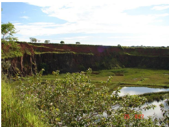
Figura 2a: Vista geral da pedreira nº 1, paralísada e com a área lavrada parcialmente preenchida por água e vegetação de gramínea. Destaque para a capa de solo de alteração, que chega neste local a 7 metros de espessura. Neste caso, quando visitada, em 25/01/2006.
