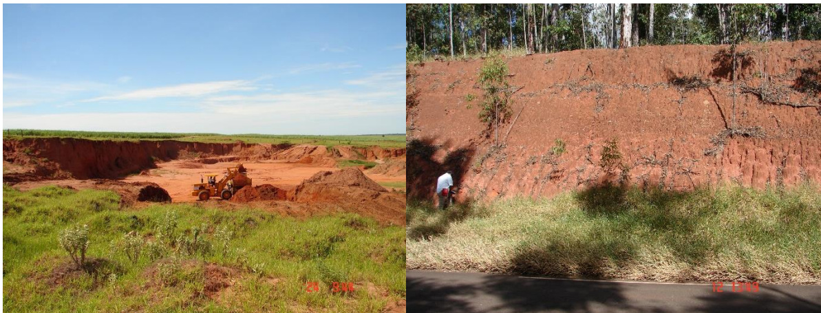
Figura 4a. Área de empréstimo, com retirada de material arenoso para uso em pavimentação de estrada, de cor vermelho amarelo, provavelmente integrante da Aloformação Paranavaí, próximo a Quatá, SP.
