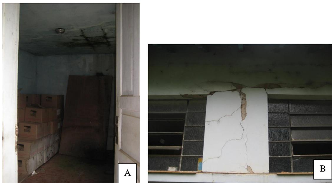
**Figura 2.2.9.1/1:** **A** – Estrutura com infiltrações, e **B** – Presença de fissuras no Centro de Visitantes provisório.
