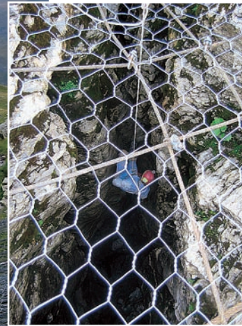
Grillage mis en place à l'entrée d'un gouffre situé sur le massif de Flaine. L'entrée du gouffre a été sécurisée pour les skieurs et son accès maintenu pour les spéléologues. Clichés Olivier Lanet et SCMB.
