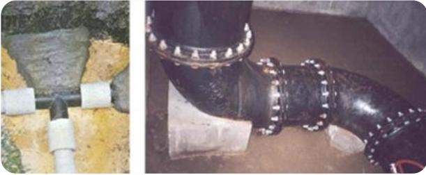
Figura 8. Anclaje en "T" y en codo.
