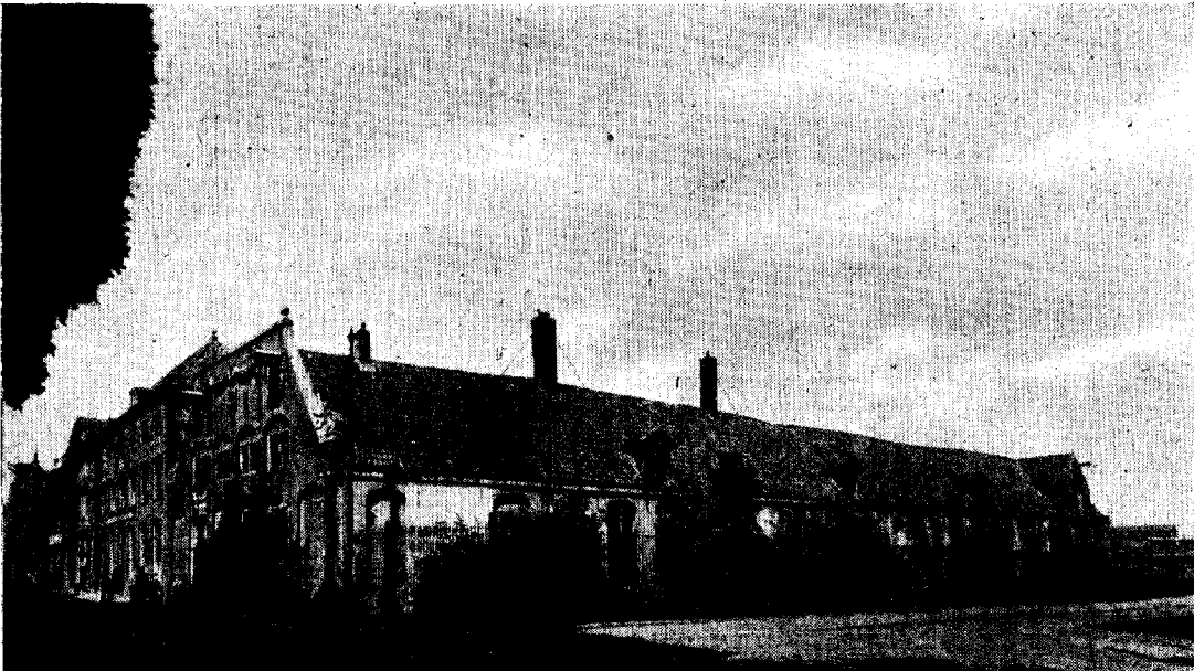
De Marine-lijnbaan, vóór het gedeeltelijk afbreken in 1939. Links de gevel van de vormalige lijnbaan der Oost-Indische-Compagnie
