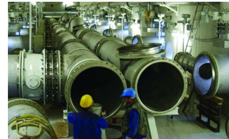
Installationskanal zwischen den Filterzellen während des Baus.
