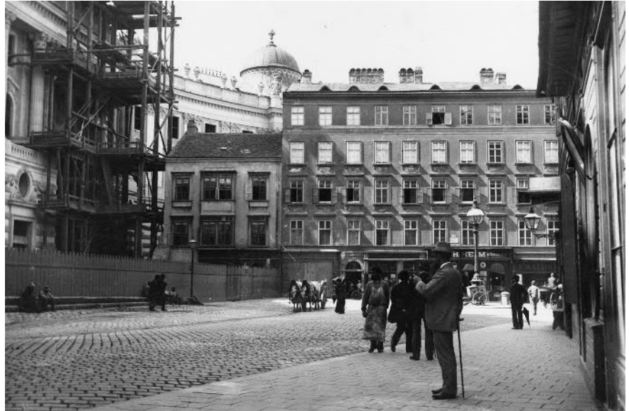
Abb. 16: Die Baustelle des Michaelertrakts und die noch verbliebenen „Stöckl“-Häuser kurz vor ihrem Abriss, 1892. (Wien Museum, Inv.-Nr. 79000/8829)
