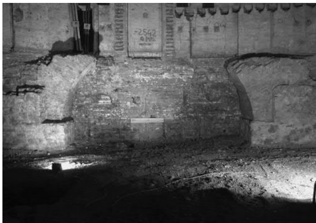
Abb. 2: Reste von Gewölben des Kaiserlichen Zeughauses. (Foto: I. Mader)
