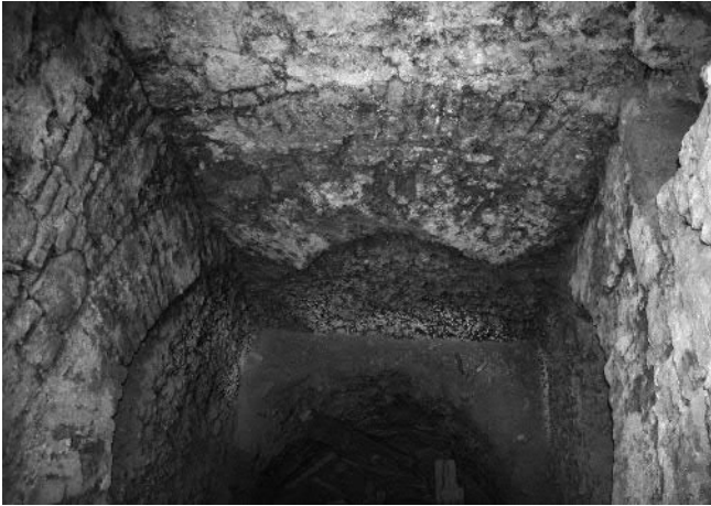
Abb. 14: Haus Nr. 5: Blick in den Entsorgungsschacht in Raum 10–11. (Foto: G. Reichhalter)
