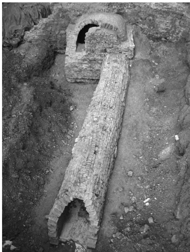
Abb. 3: Rest des freigelegten Minenganges, Blick nach Westen. Im Hintergrund der ehemals unterirdische, östliche, tonnengewölbte Raum mit den links und rechts anschließenden Mauern der Stiegenaufgänge. (Foto: H. Krause)
