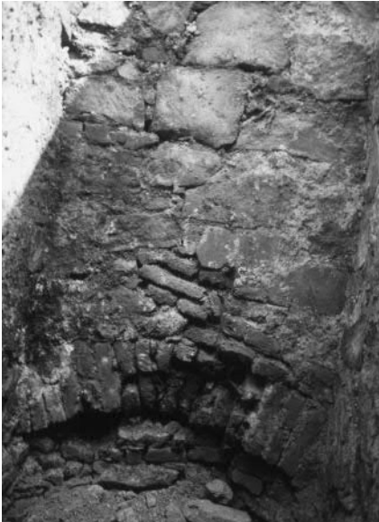
Abb. 21: Detail des Suchschnittes im Bereich der Schauflergasse mit dem ehemaligen Brunnen-schacht, Ansicht von Süden. (Foto: Stadtarchäologie Wien)
