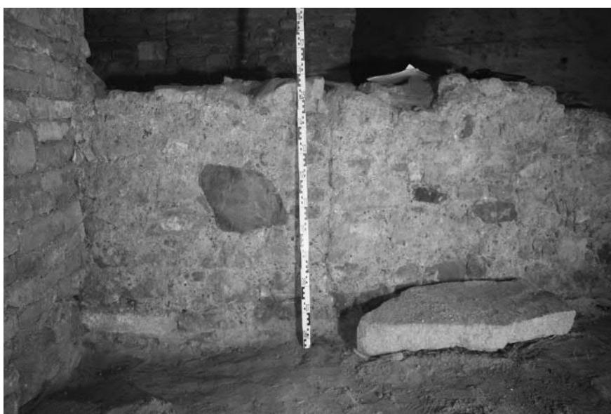
Abb. 9: Haus Nr. 5: mittelalterlicher Mauerrest in Raum 4–5, rechts der Messlatte Baunaht. (Foto: G. Reichhalter)
