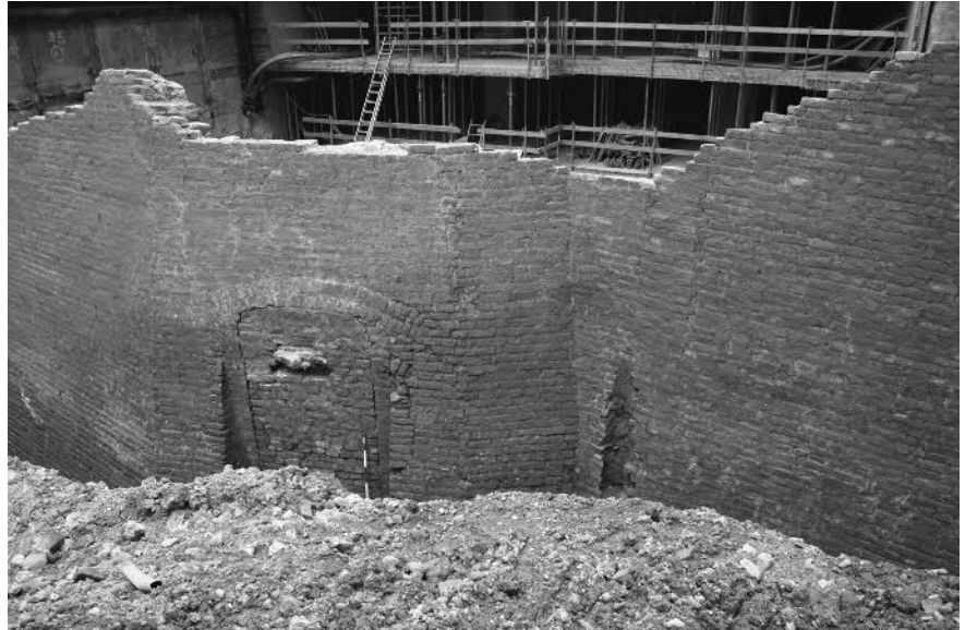
Abb. 2: Reste der Kontereskarpe vom ehemaligen Stadtgraben aus gesehen, Blick nach Osten. In der Bildmitte die vermauerte Türöffnung. (Foto: G. Reichhalter)
