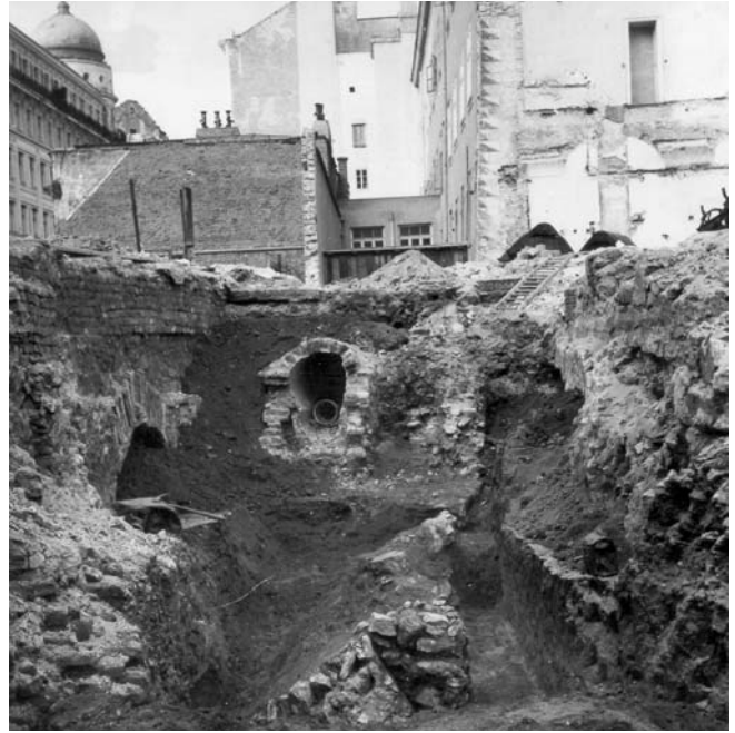
Abb. 3: Ansicht der abgerutschten oder gekippten Lagermauer A 3 im Bereich der Baustelle Wien 1, Am Hof 9 im Jahr 1953, Blickrichtung Norden. (Foto: Wien Museum, Inv.-Nr. 16013/34)
