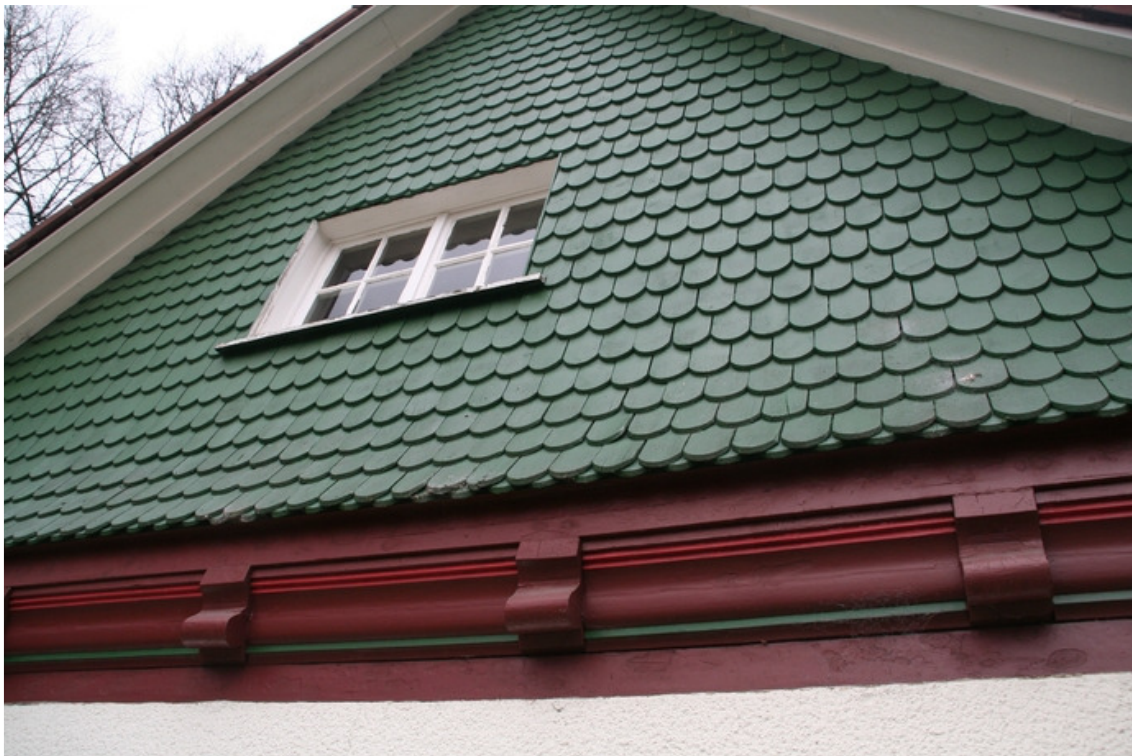
Abb. 7: Holzelemente auf der Giebelseite
