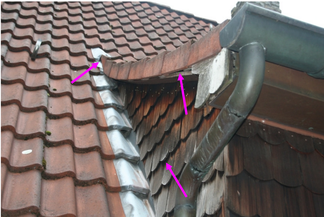
Abb. 6: Detail der Schleppegabe mit potenziellen Spaltenquartieren
