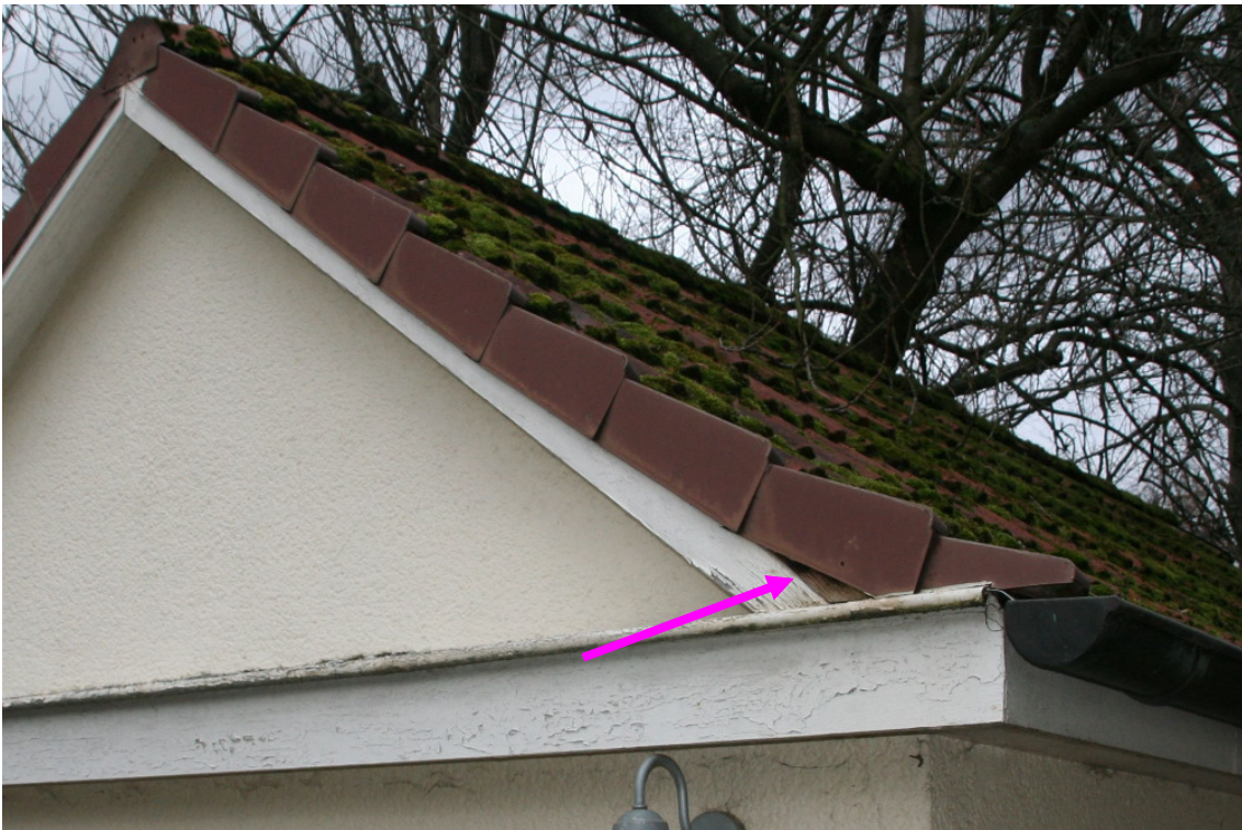
Abb. 9: Dachbereich der Garage mit potenziellen Spaltenquartieren
