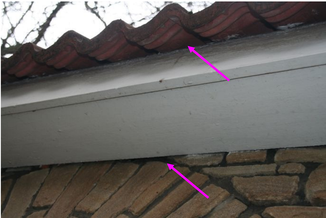
Abb. 10: Dach des Torbogens mit potenziellen Spaltenquartieren
