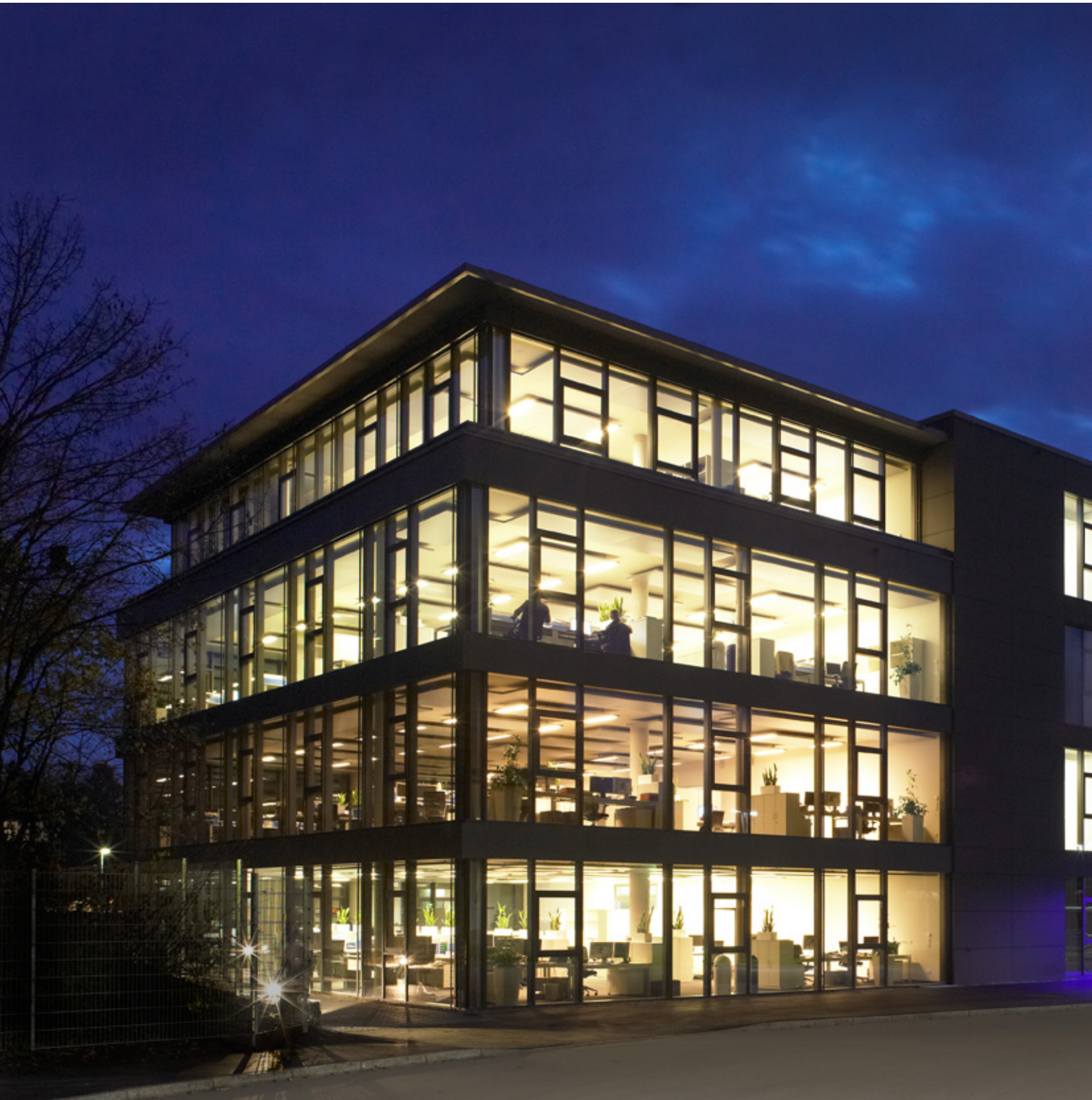
BHS-Sonthofen 公司总部办公楼
