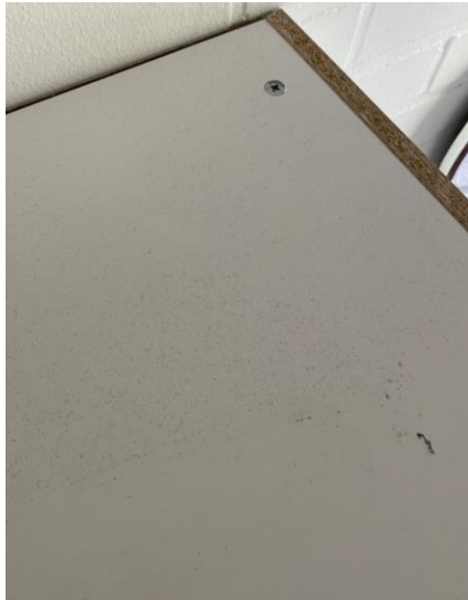
Kuva 15. Ylätasopinnoilla havaittiin runsaasti pölyä. Kuva tilasta 112.
