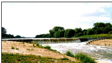
Regulierte Luppe am Auslauf des Elsterbeckens. Durch die extrem tiefe Lage des Flussbettes entsteht zusätzlich eine Dränagewirkung, was zum Absenken des Grundwasserspiegels führt.
