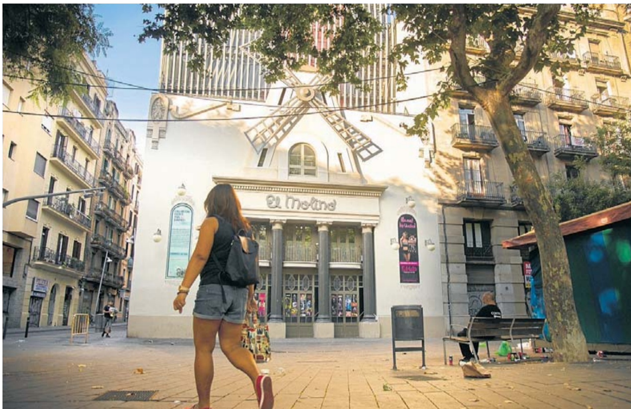
Façana d'El Molino, que a partir d'ara serà un equipament municipal. WAYRA FICAPAL
