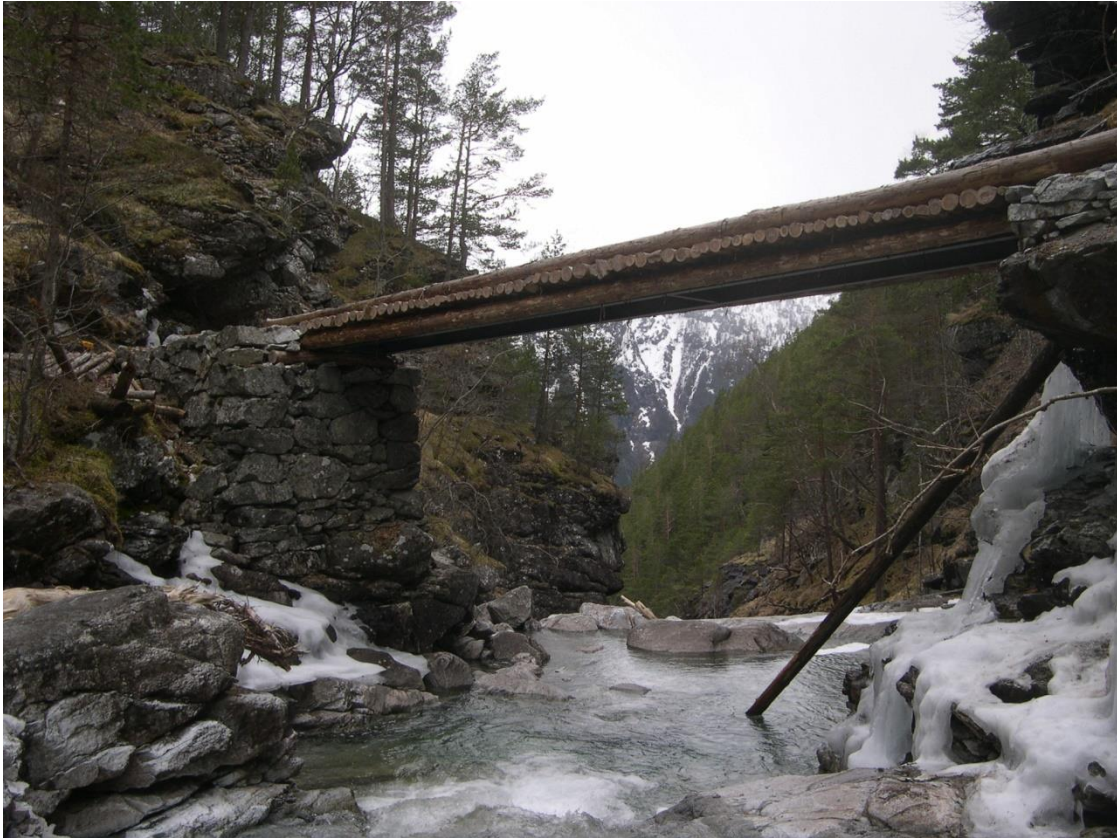
Brua over hovedelvi er 12-13 meter lang og vart fornya i 2007.
