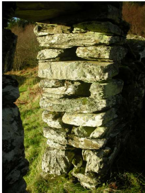
Structure 2 door frame
