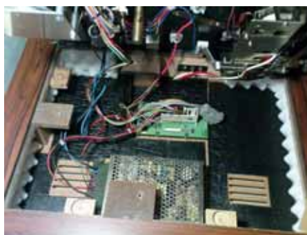
Provisorisch „gestrickte“ Steuerung und Netzteil
