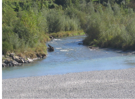
Abbildung 5: Liechtensteiner Binnenkanal, niveaugleiche Mündung in den Alpenrhein. .
