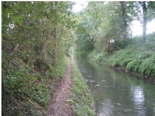
Abbildung 19: Ehbach – gleichförmiges Gerinne mit trapezförmigem Profil.
