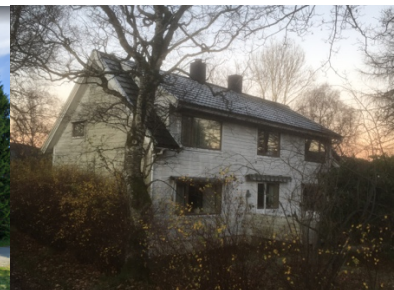
Figur 2c. Bolig som skal rives
