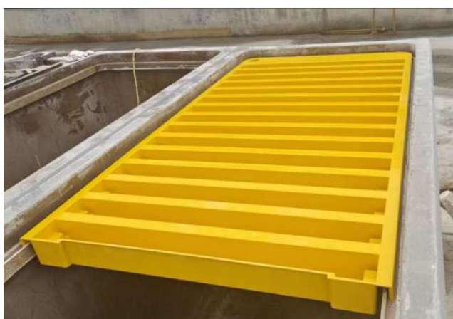
图 9.2-2 电积槽酸雾定向收集装置展示图
