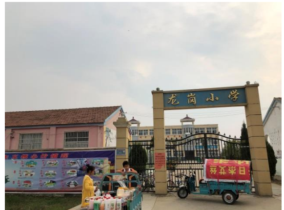
14 五河县武桥镇龙岗小学、龙岗幼儿园
