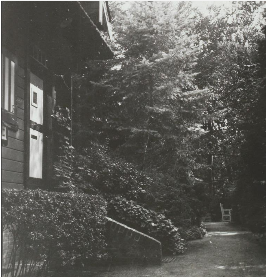
Afb. 7. De westelijke zijde van 't Blokhuis te Breda, met de voordeur met bovenlicht en glasluikje met ijzeren kruis. (bron: BD#001.)
