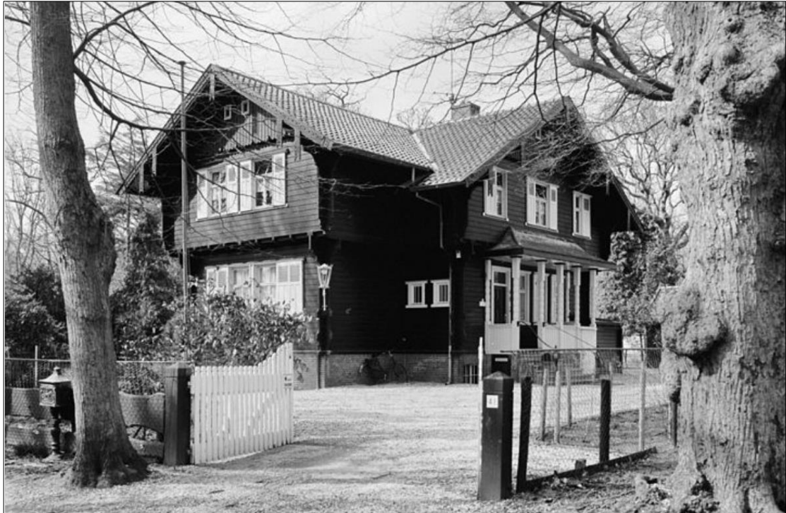
Afb. 5. Het blokhuis aan de Kennemerstraatweg 41 in Heiloo, omstreeks 1920 gebouwd voor de heer mr. C.J. de Lange. (foto: G.J. Drukker, RCE, 1993.)
