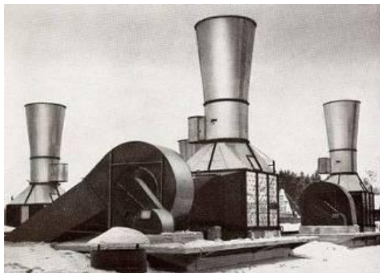
15) Potkuripuhaltimia mallia PFM sov. 10, keskisäköpuhaltimia mallia VLT sov. 5 sekä lämmönalteenottojärjestelmiä. Enson Kartonkitehdas.
