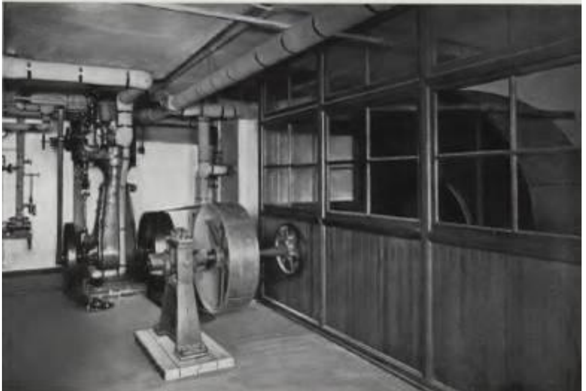
Mualla rikkaammissa maissa kouluihin koneellinen ilmanvaihto tuli paljon Suomea aiemmin. Kuvassa koulun ilmastointikoneen ratkaisu 1910 Yhdysvalloissa. Puhallin on eristetty omaan puusta ja ikkunalaseista tehty huoneeseensa. Puhallinta pyörittävä höyrykone hihnakäyttöineen on ulkopuolella. Hihnasuojuksista ei tuolloin taidettu edes uneksia. (Am)
