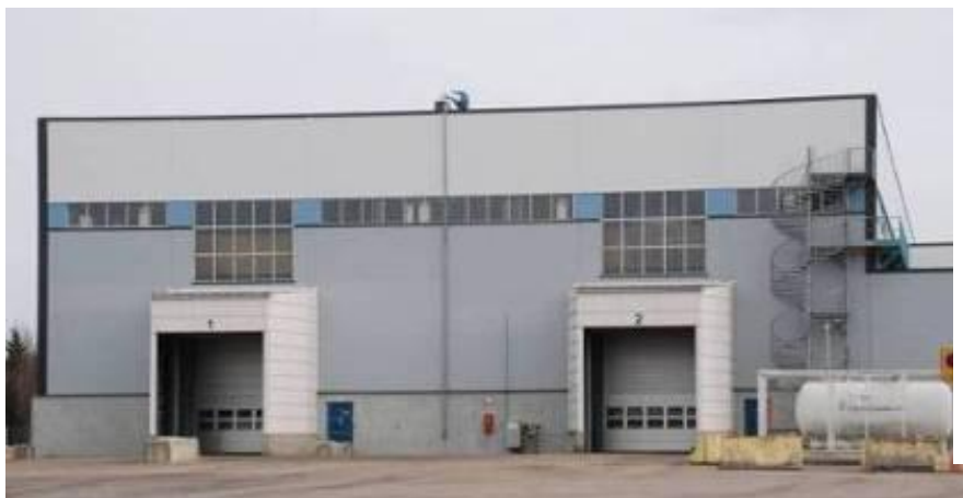
Tunneliportteja entisen Valmetin putkitalahtaan ja nykyisen kattilavalmistuosaston ovissa. (kuva BHa)
