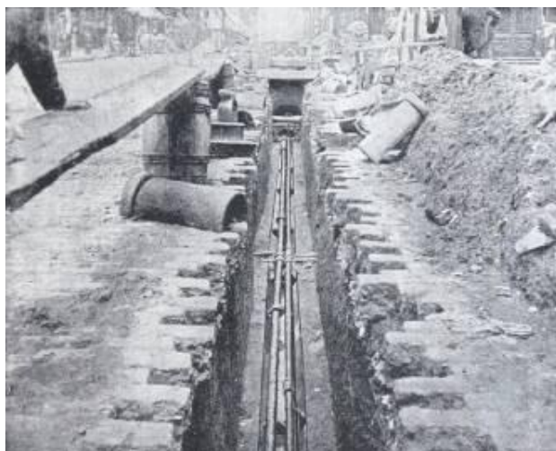
Kaukojäähdytysputkien asennusta New Yorkissa 1891. (Am)
