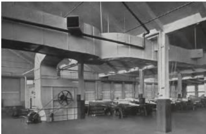
Teollisuuden ilmanvaihtolaitteet ovat olleet aika järeitä, mutta ratkaisut sinneleitä. Pääasia ilmanajossakin vuodelta 1915 näyttää olleen, että ilma lentää pitkälle. (Am)
