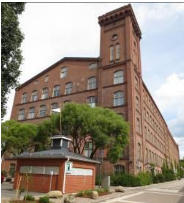
1900 valmistuneen Tampereen Lapinnimen puuvillatehtaan mainitaan olleen Suomen ensimmäinen jo alunpitäen kokonaan sprinklattu rakennus.
